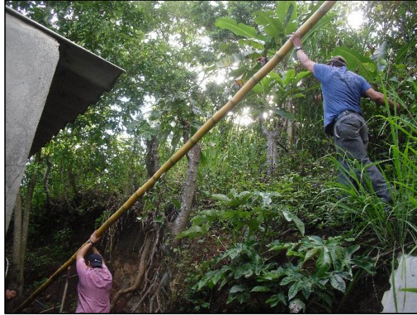
Figura. 4.14 Instalación del router en el nodo TORRES.
