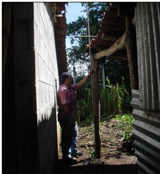
Figura. 4.6 Instalación del router en nodo ARGUETA.
