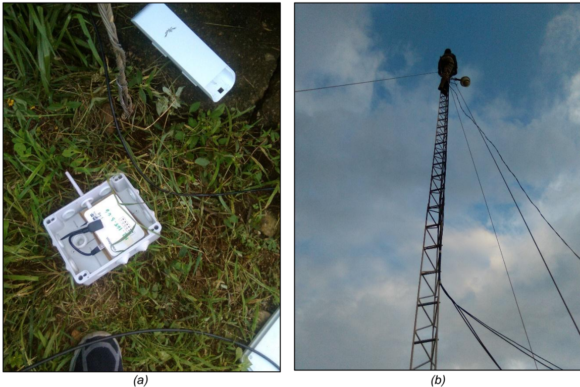
Figura. 4.32 (a) Cambio de router MP02 por router NS M2, (b) Instalación de router NS M2 en nodo WALEJO.
