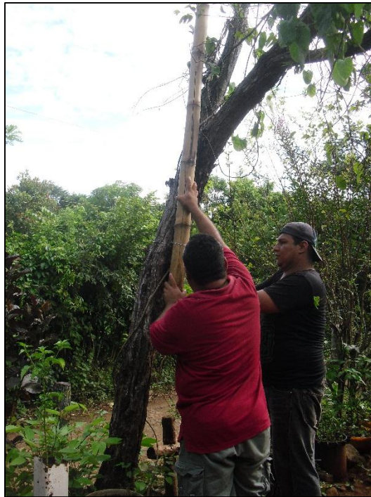
Figura. 4.3 Instalación del router en nodo LAINEZ.
