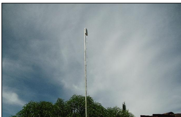
Figura. 4.7 Router instalado en nodo ARGUETA.
