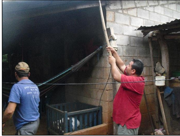
Figura. 4.16 Instalación del router en el nodo adicional MIGUEL.
