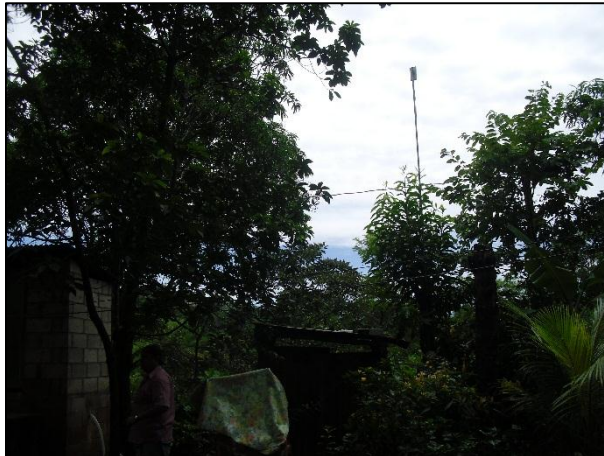
Figura. 4.11 Router instalado en nodo LEIVA.
