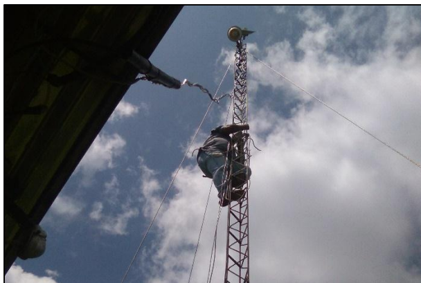
Figura. 4.24 William instalando el router en el nodo WALEJO.
