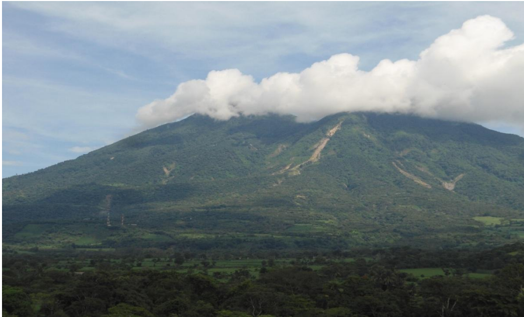
FOTOGRAFIA 1. Volcán Chichontepec, en él se muestran cada una de las grietas provocadas durante la Tormenta IDA en el año 2009, las cuales generaron deslizamientos que afectaron a todos las Comunidades en estudio.
