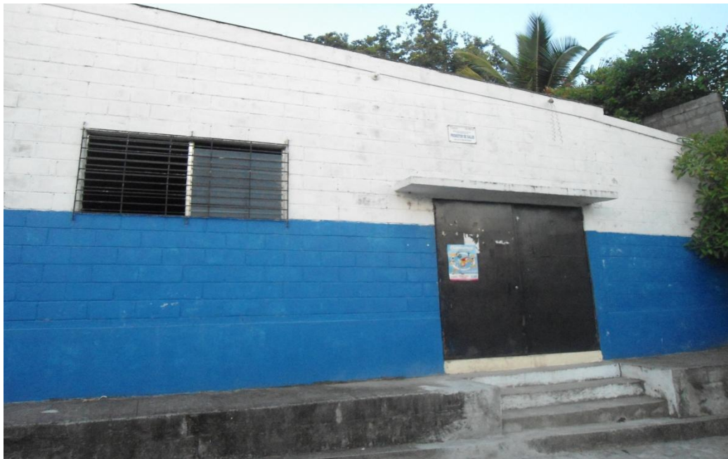
FOTOGRAFIA 4. Casa Comunal de la comunidad de San Jerónimo El Limón, en algunas ocasiones es utilizada para jornadas médicas, no es útil para servir de albergue ya que no cuenta con las condiciones principales y necesarias
