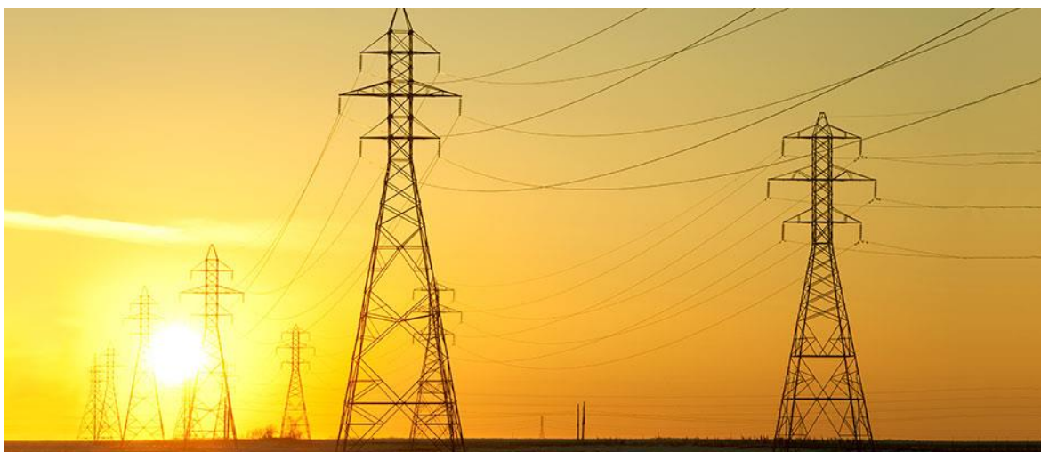
Figura 1. 5 Torres para sistema de transmisión a alta tensión 3
