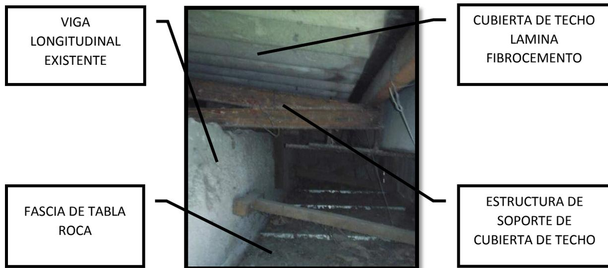
Fotografía 7: Detalle de estructura actual de soporte de techo y materiales.
