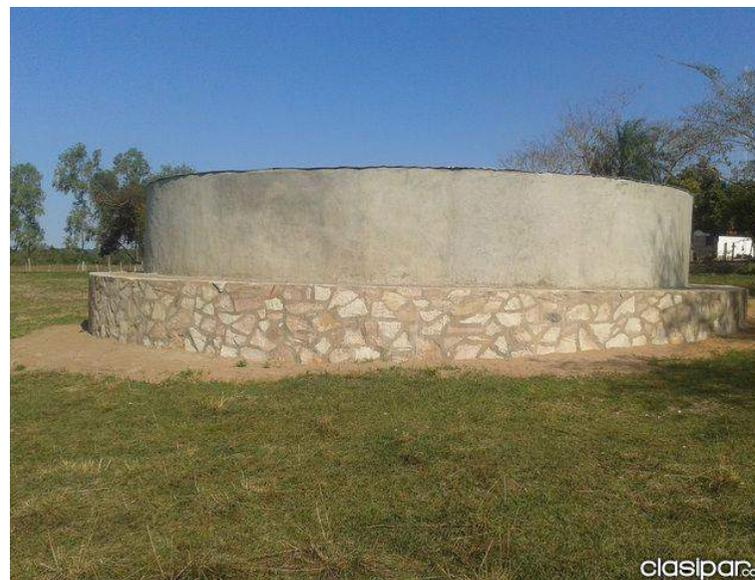
Foto 19 Tanque de ferrocemento con capacidad mayor a las domiciliarios.
