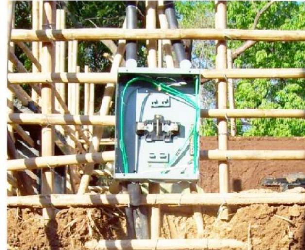
IMAGENES ILUSTRATIVAS DE LA COLOCACIÓN DEL TABLERO ELÉCTRICO Y ,Y TOMACORRIENTES EN LAS PAREDES DE BAHARQUE. UNICAS PARTES EN DONDE SE DEJA SIN RELLENO LA PARED PARA SU UBICACIÓN. SI BIEN LOS INTERRUPTORES NO SE MUESTRAN EN LA IMAGEN, SE UTILIZA EL MISMO PROCESO PARA ESTOS.
