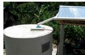
Foto 24 Tanque de ferrocemento para captación de A.LL.
