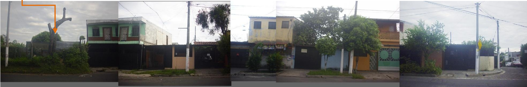
Imagen 39: Tramo 2 perfil Calle el Bambú, inmueble fuera de la línea de construcción al final de la vía.
