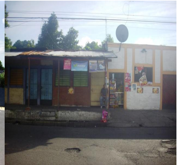
Fotografía 4: Av. Principal muestra la falta de continuidad por aceras elevadas.
