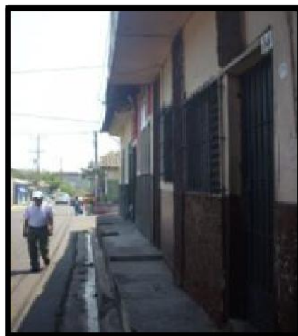
Fotografía 22: Peatón camina sobre la vía, cambios de nivel en acera obligan a esto.
