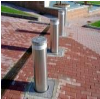
Imagen 15: Bolardos de Protección fija.
