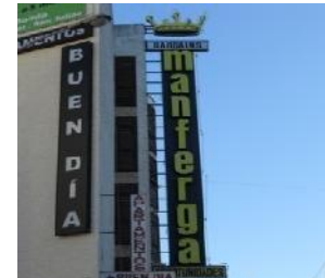
Imagen 25: Rotulación perpendicular a fachada.
