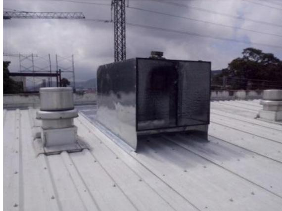
**Figura 7: Sistema de extracción de aire en lavandería.**
