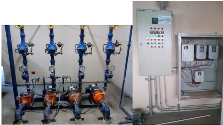
**Figura 4: Manifold de la distribución de agua y tablero de montaje de los variadores.**
