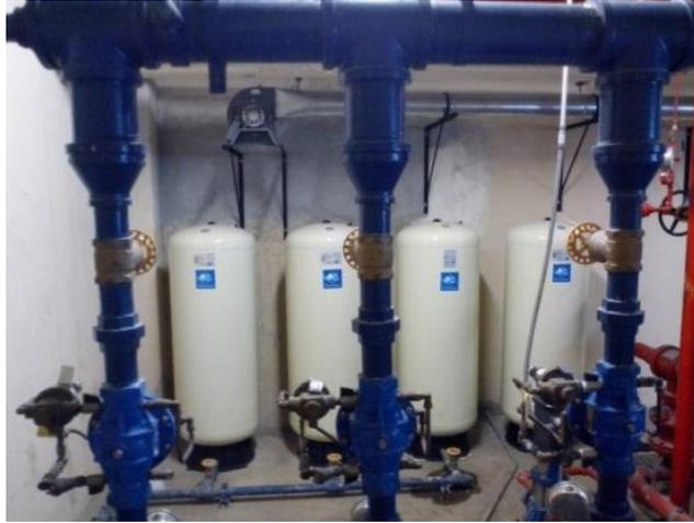
**Figura 5: Tanques hidroneumáticos del sistema de bombeo.**
