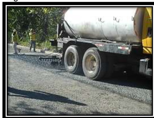
Imagen 4.24 Aplicación de emulsión para la segunda capa de 3/8".
