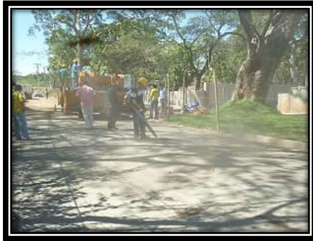
Imagen 4.7 Limpieza de la Base.
