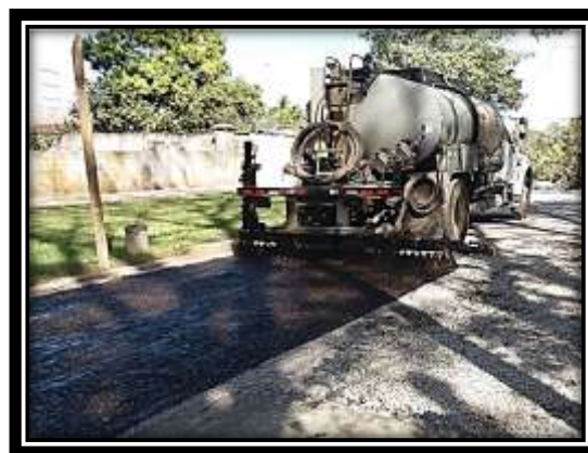
Imagen 4.17 Aplicación de emulsión para la segunda capa de 3/8".
