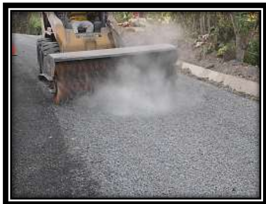
Imagen 4.29 Limpieza del exceso en la primera capa del tratamiento superficial doble.
