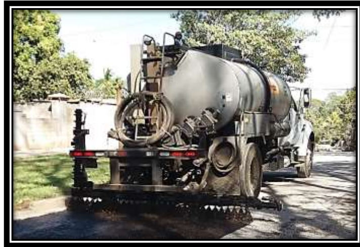
Imagen 4.1 Distribuidor de Asfalto.
