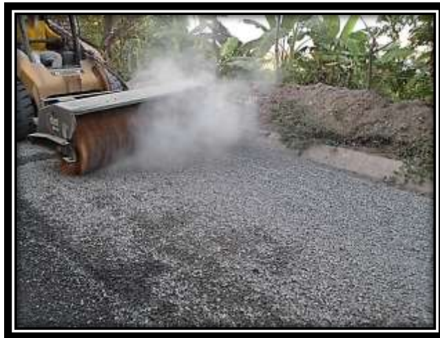
Imagen 4.13 Barrido del exceso de agregado.
