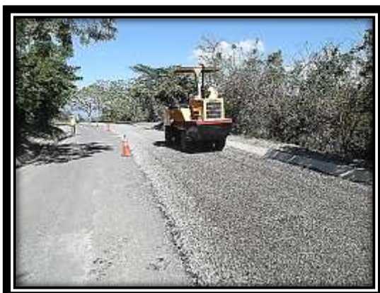
Imagen 4.27 Compactación de la primera capa del tratamiento superficial doble.
