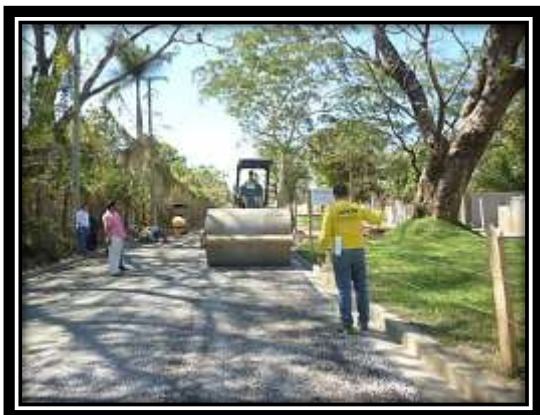
Imagen 4.20 Compactación de la primera capa del tratamiento superficial.
