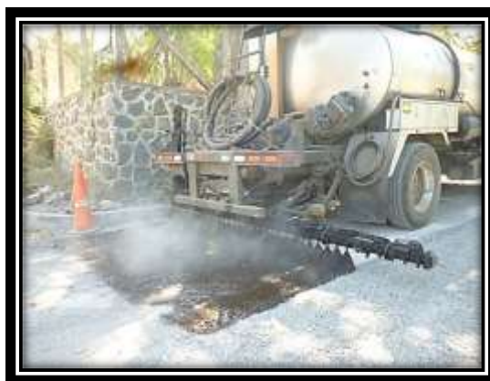
Imagen 4.16 Aplicación de emulsión para la primera capa de 3/4".
