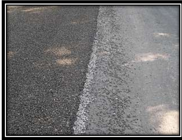
Imagen 4.12 Junta Longitudinal.
