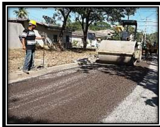
Imagen 4.21 Compactación de la segunda capa del tratamiento superficial.
