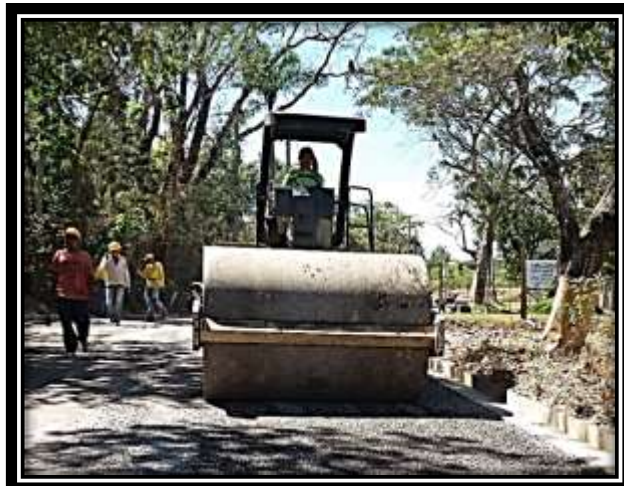
Imagen 4.10 Compactación con rodillo liso.
