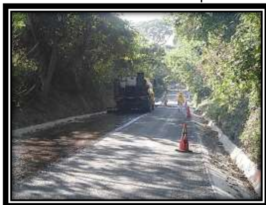
Imagen 4.23 Aplicación de emulsión para la primera capa de 3/4".
