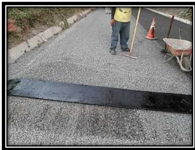
Imagen 4.11 Junta Transversal.
