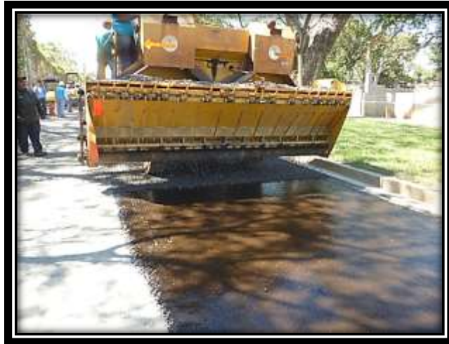
Imagen 4.9 Aplicación de la distribución de agregados.
