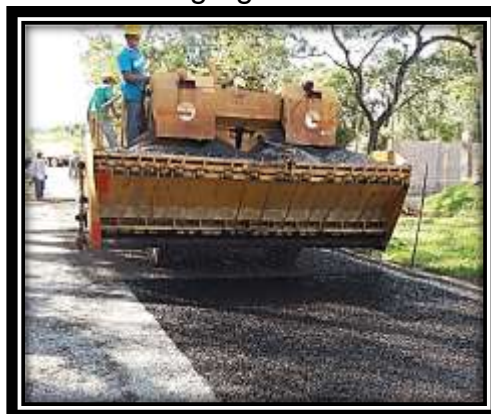
Imagen 4.19 Aplicación de agregado para la segunda capa de 3/8”.
