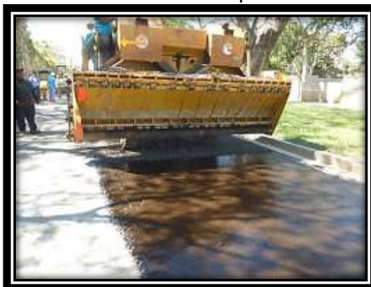
Imagen 4.18 Aplicación de agregado para la primera capa de 3/4”.
