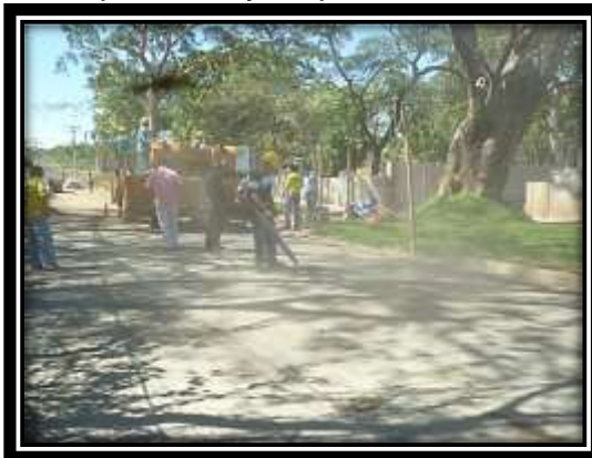
Imagen 4.15 Limpieza de la base.
