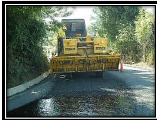
Imagen 4.26 Aplicación de agregado para la segunda capa de 3/8”.
