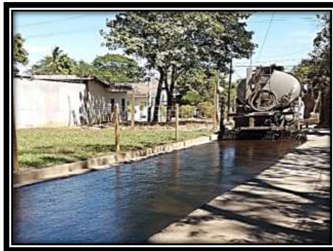
Imagen 4.8 Riego de Emulsión Asfáltica.
