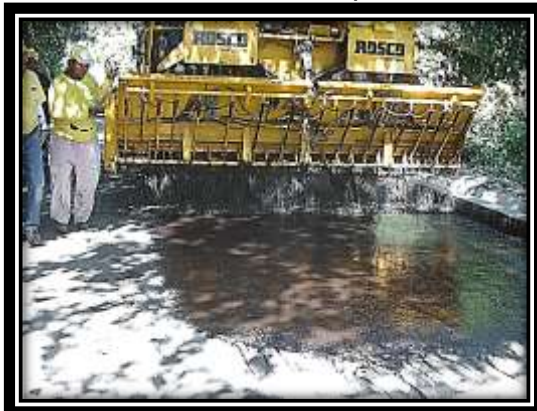
Imagen 4.25 Aplicación de agregado para la primera capa de 3/4”.
