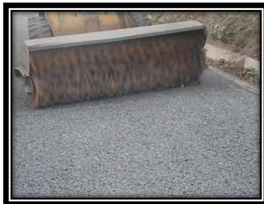
Imagen 4.30 Limpieza del exceso en la segunda capa del tratamiento superficial doble.
