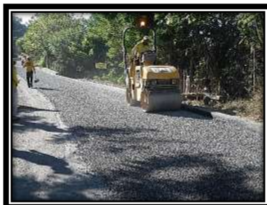
Imagen 4.28 Compactación de la segunda capa del tratamiento superficial doble.
