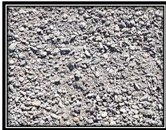
Imagen 2.6 Aplicación de tratamiento superficial mal graduado.
