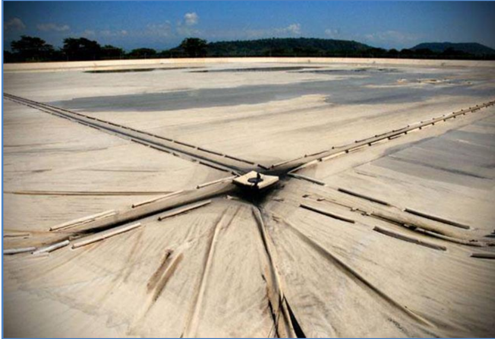
Figura 2.9 Reservoirio de agua tratada de planta potabilizadora Las Pavas.
