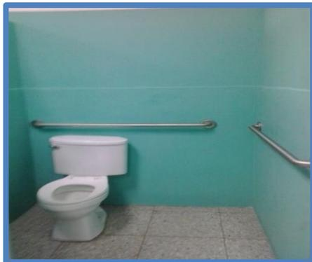
*Barras de apoyo en posición horizontal atrás del inodoro y a un lado. Palanca de descarga de agua.*
