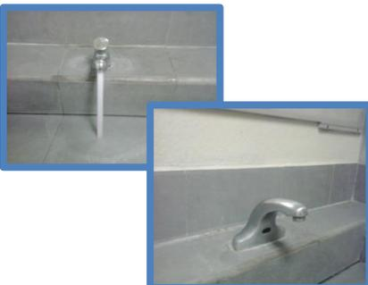
*Grifería de los lavamanos se activan por sensor o un solo movimiento de presión hacia abajo, y la descarga de agua de los inodoros requieren un solo movimiento.*
