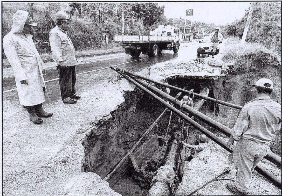
San Marcos ▲ Obreros de la Anda reubicaron una tubería de agua potable, dañada por un derrumbe en la calle antigua a Zacatecoluca.
