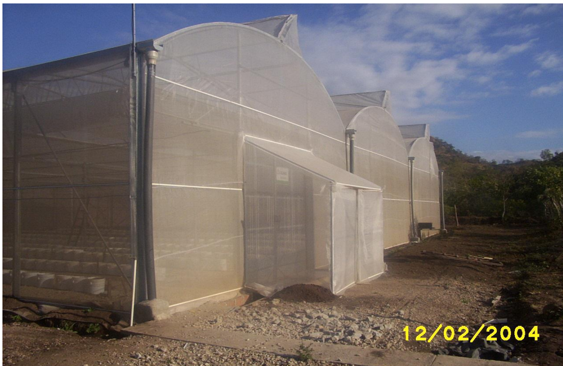
FOTO 2: FACHADA DE INVERNADERO DE ALTA TECNOLOGÍA
