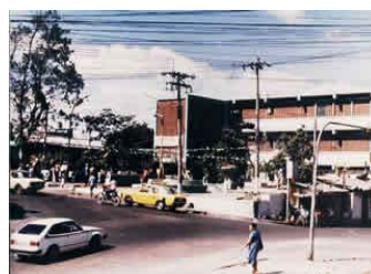
Edificio de Alcaldía Municipal de Mejicanos Deteriorado por Terremoto de 1986.
