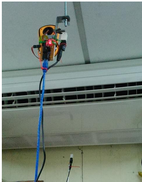
Figura 3.1-6. Instalación de sensores de humedad y temperatura y anemómetro.
