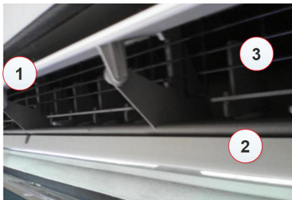
Figura 1.4-1. Posición correcta de difusores para medición [23].
