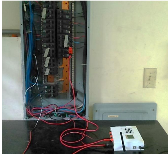
Figura 3.1-5. Conexión sub-sistema 2 (medición de potencia).
