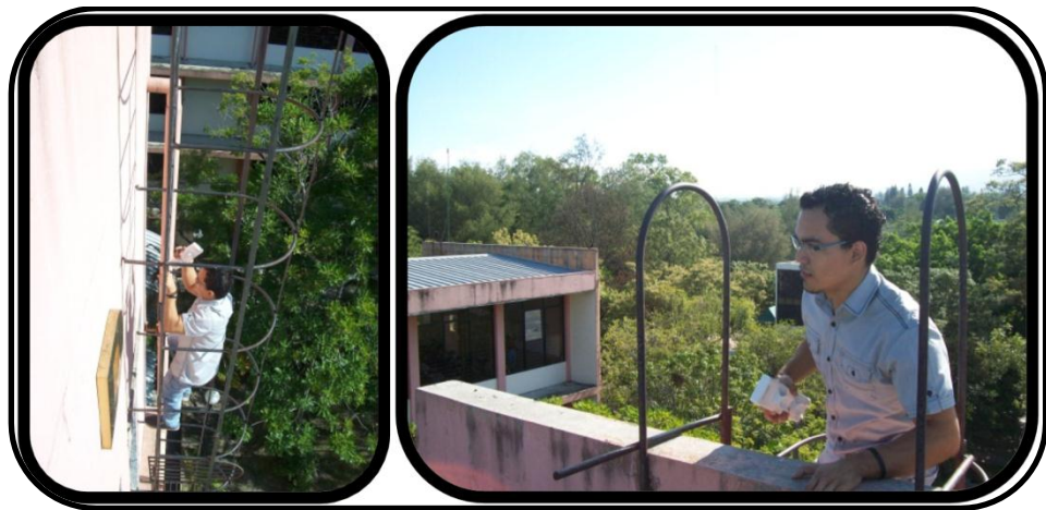
Figura 3 Subiendo por escalera inadecuadamente y sin equipo de seguridad personal.
