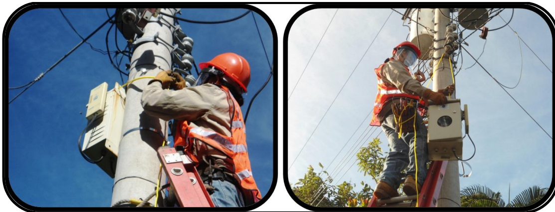
Figura 11 Retiro de equipo dañado.
