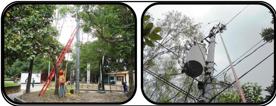
Figura 9 Realizando corte de energía.
