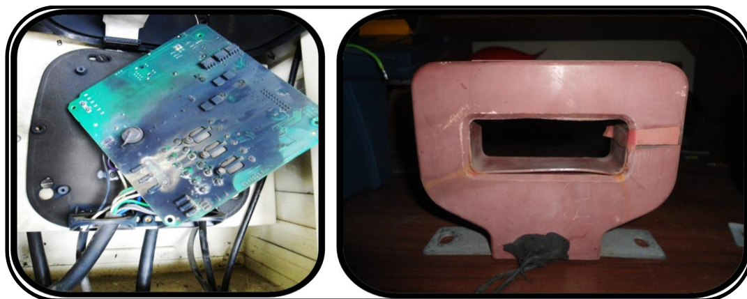
Figura 12 Inspección sensorial con revisión de medidor y bobinas.
