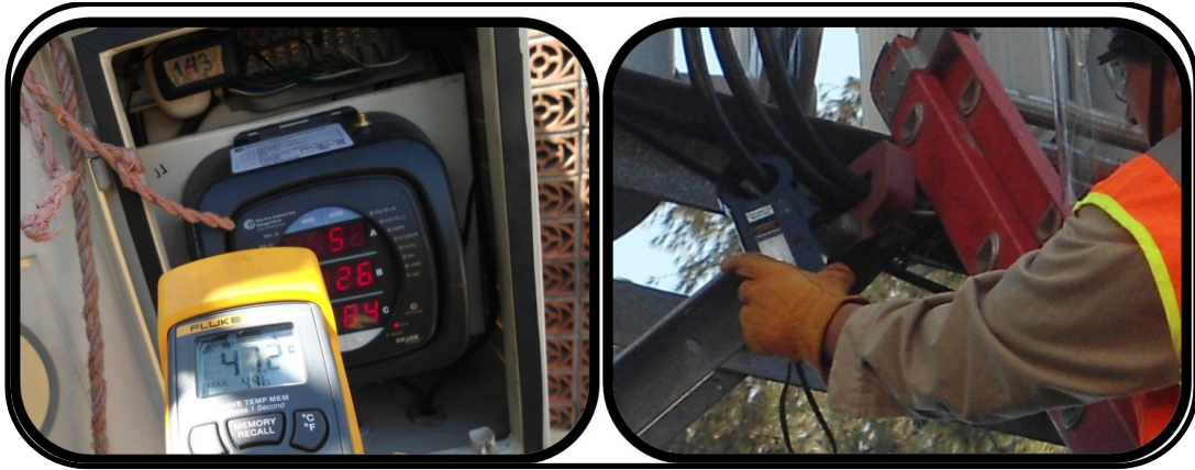
Figura 8 Toma de lecturas de temperatura y corriente.
