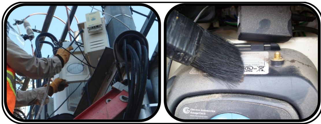
Figura 7 Realizando limpieza técnica en poste.
