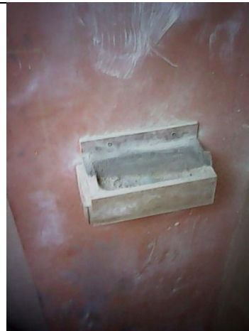
Acumulación excesiva de tiza
