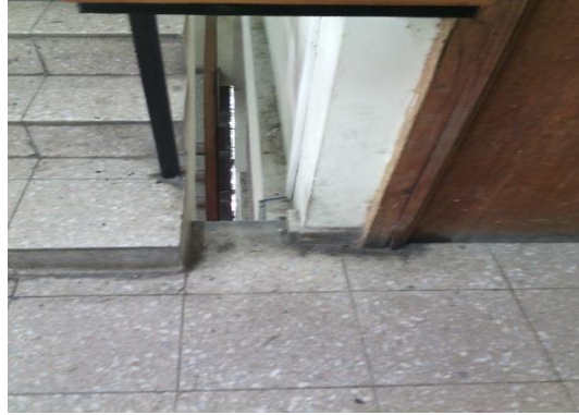
Riesgo de caída a distinto nivel por falta de pasamanos y superficie antideslizante.
