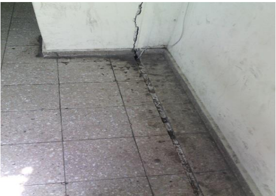
Riesgo estructural por fisuras y grietas en las paredes de la escuela. (Tercera Planta en los pasillos)
