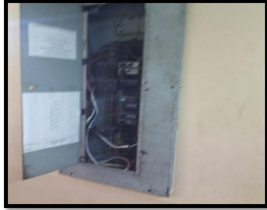
Riesgo Eléctrico por tomacorriente y dados sin protección (Zona de Cubiculos).
