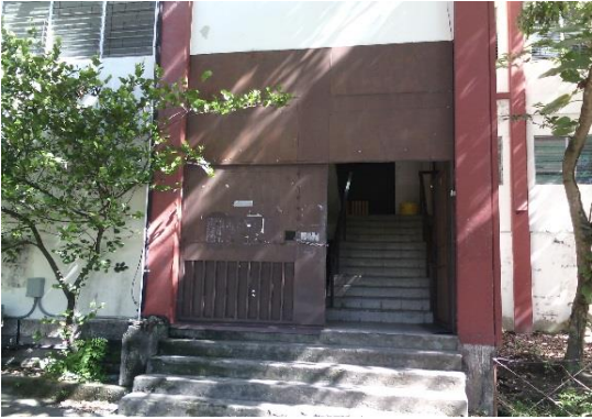
Riesgo de caída a distinto nivel por falta de pasamanos y superficie antideslizante.
