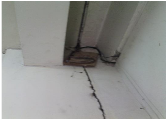
Riesgo estructural por fisuras y grietas en las paredes de la escuela. (Tercera Planta en los pasillos)
