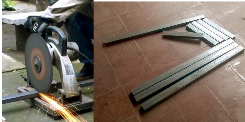
Fig. 3.1. Corte de los tramos de tubos en base las medidas del plano.
