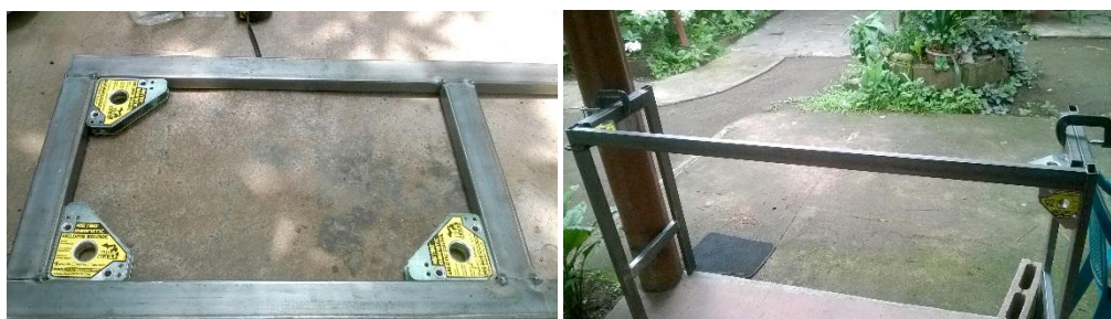
Fig. 3.2. Preparación de juntas mediante puntos, y armado de la bancada.
