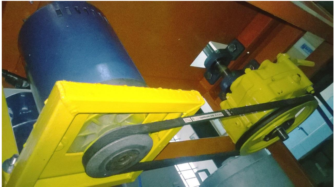
Fig.3.12. Motor y reductor instalados y acoplados.
