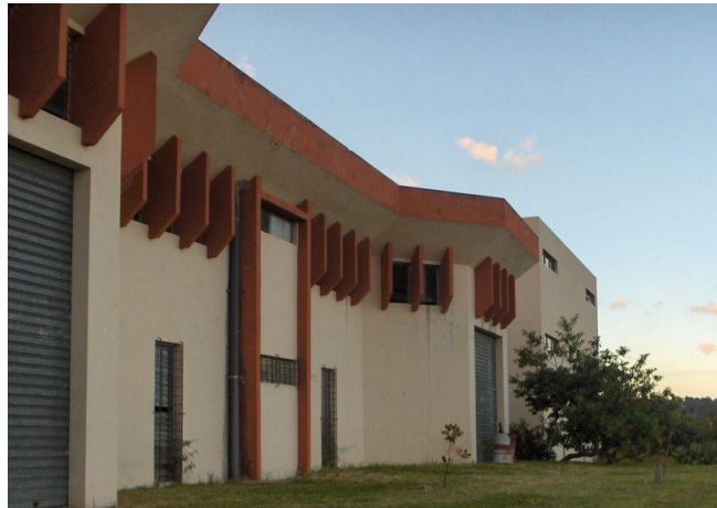
Ilustración 35: Costado Este del Edificio de Potencia.
