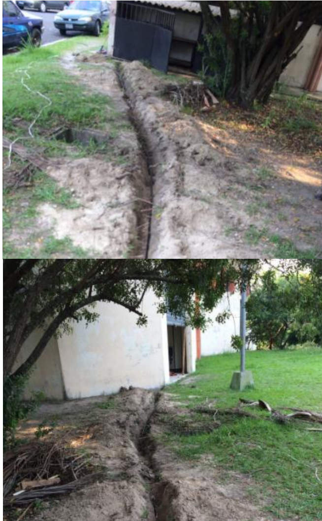
Ilustración 57: instalación subterránea entre los edificios.
