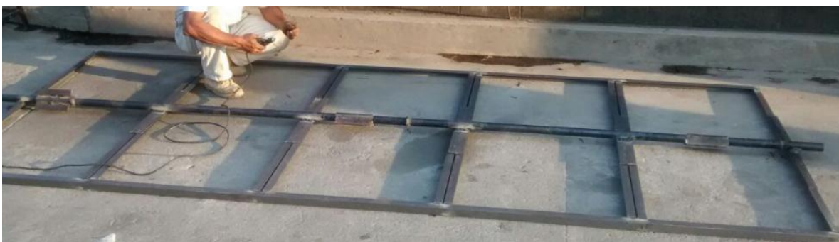
Ilustración 49: Eje pre ensamblado con el marco soporte de los páneles.
