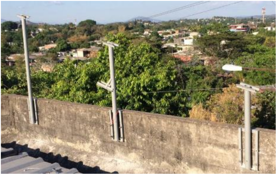
Ilustración 50: Instalación de las columnas de la estructura
