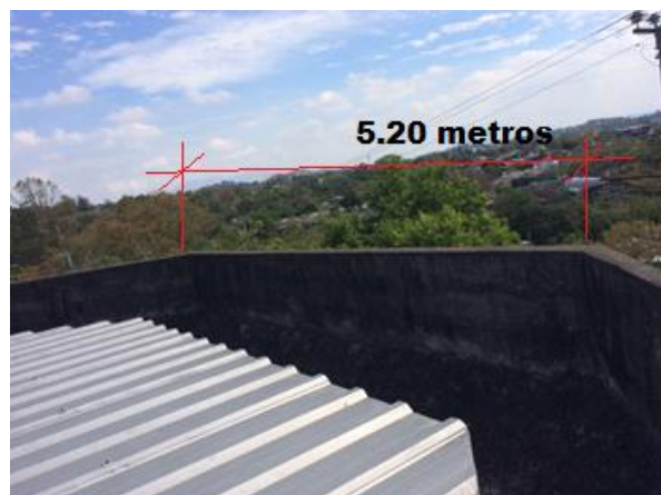
Ilustración 36: Ubicación exacta, costado Este del Edificio de Potencia
