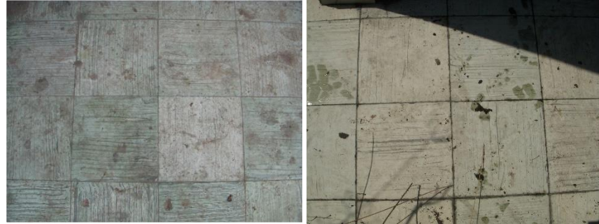
Fotografía N°17: Material No Estructural de Casa Salaverría Fuente: Equipo de investigación
