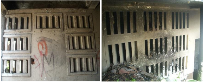
Fotografía N°19: Material Estructural de Casa Salaverría Fuente: Equipo de investigación
