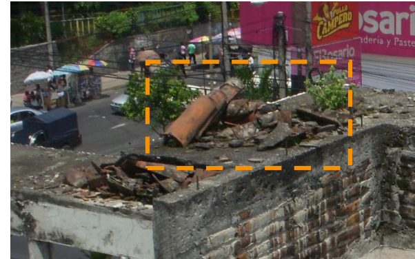
Fotografía N°14: Material No Estructural de Casa Salaverría Fuente: Equipo de investigación
