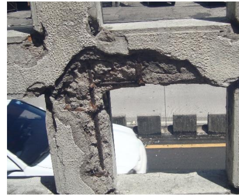
Fotografía N°12: Material Estructural de Casa Salaverría Fuente: Equipo de investigación
