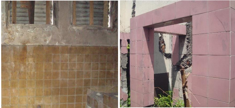
Fotografía N°15: Material No Estructural de Casa Salaverría Fuente: Equipo de investigación
