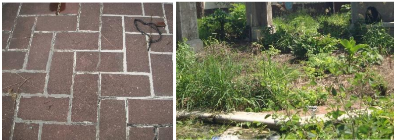
Fotografía N°16: Material No Estructural de Casa Salaverría Fuente: Equipo de investigación
