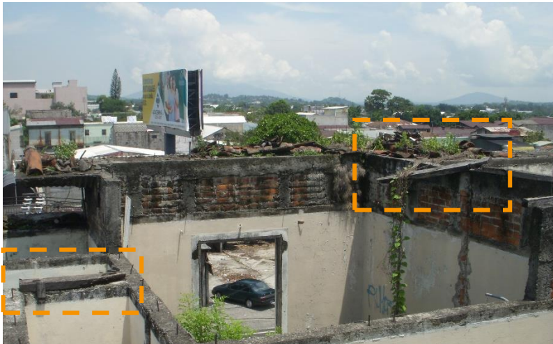
Fotografía N°11: Material Estructural de Casa Salaverría Fuente: Equipo de investigación
