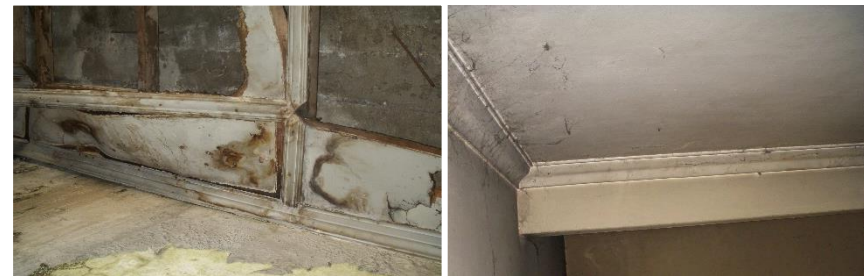
Fotografía N°18: Material No Estructural de Casa Salaverría Fuente: Equipo de investigación
