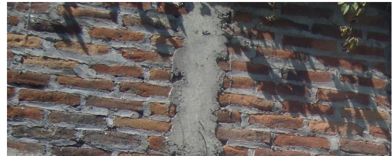
Fotografía N°10: Material Estructural de Casa Salaverría Fuente: Equipo de investigación
