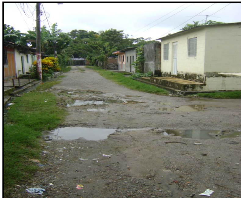
Calle de la colonia San Martín en mal estado por lluvias.
