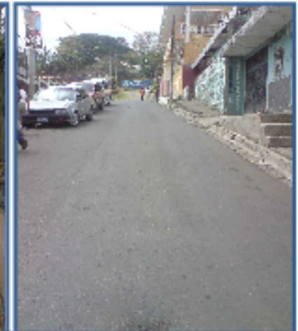
Calle Asfaltada: 3º. Calle Pte.
