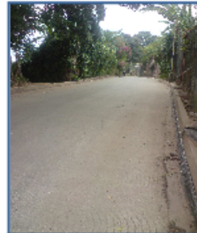
Calle Concreteada: 8º. Av. Sur
