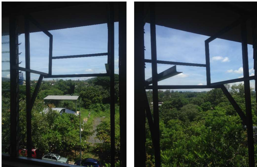
Fig. 3.4. Estructuras de soporte de los equipos de aire acondicionado
