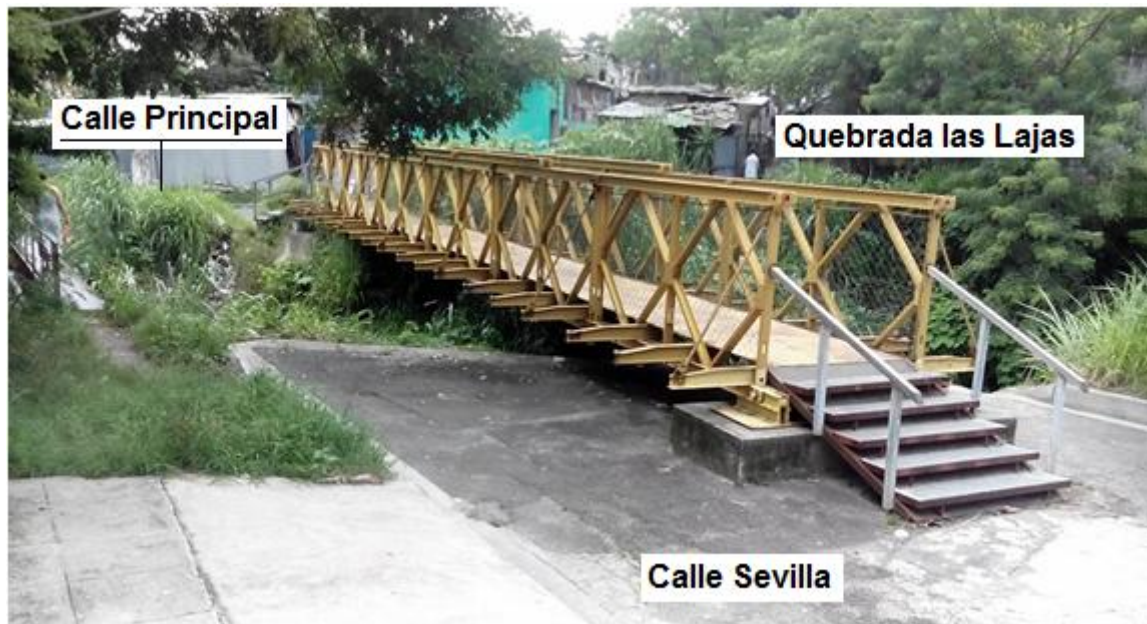
Fotografía 5. 1 Puente Bailey en emplazamiento de estudio en Colonia Lorena, Mejicanos.
