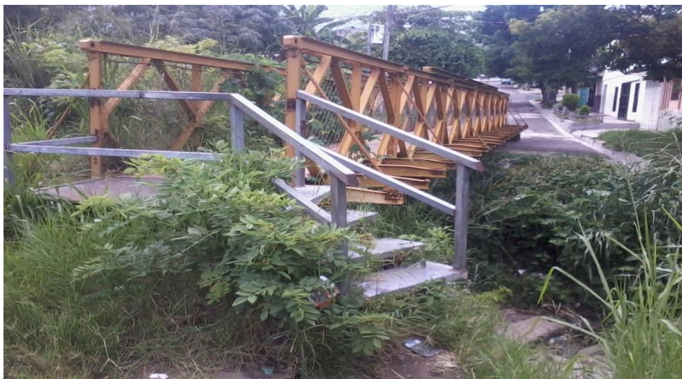
Fotografía 5. 3 Puente peatonal tipo Bailey, en el emplazamiento de estudio.
