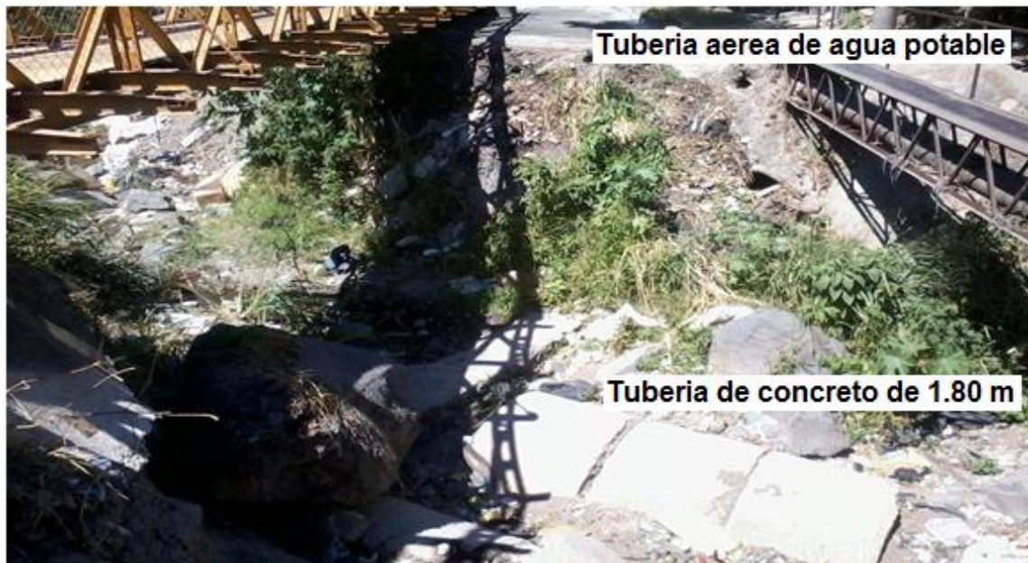
Fotografía 5. 2 Condiciones del cauce, tubería de concreto y tubería de agua potable.
