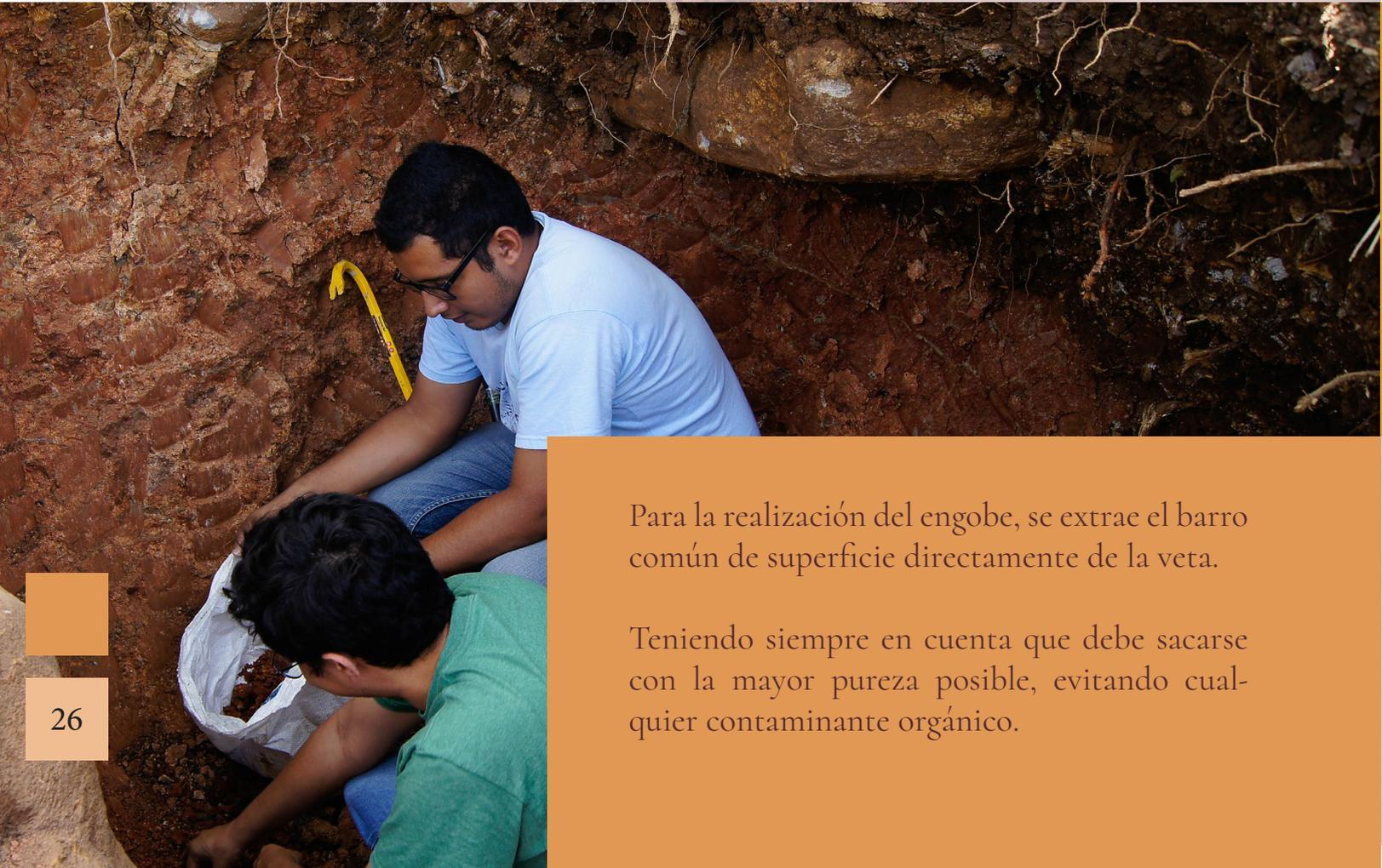
Para la realización del engobe, se extrae el barro común de superficie directamente de la veta.
