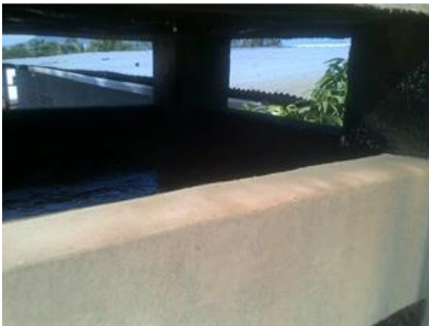
Cajas de Oxigenación con material de roca volcánica.
