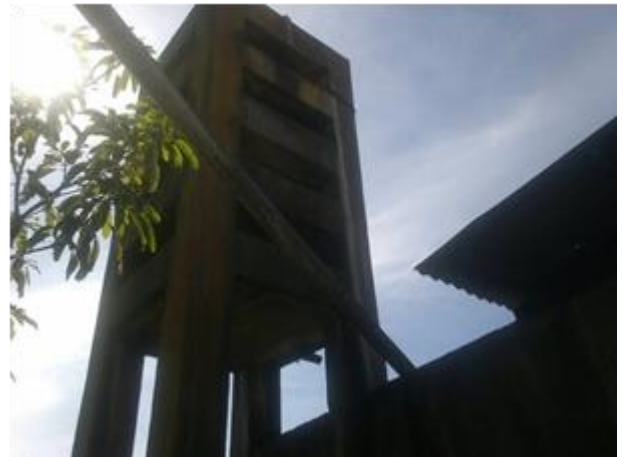
Sistema de caída para la Oxigenación del agua y precipitar el Hierro como Hidróxido de Hierro.
