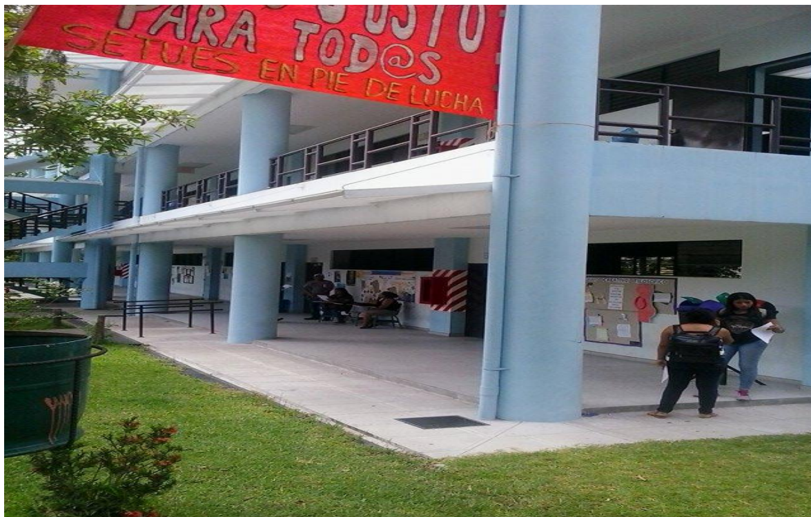
FUENTE: Fotografía tomada por investigador(as) en Proceso de Grado de Licenciatura en Trabajo Social, del edificio Dagoberto Marroquín, 28 de mayo de 2016.”
