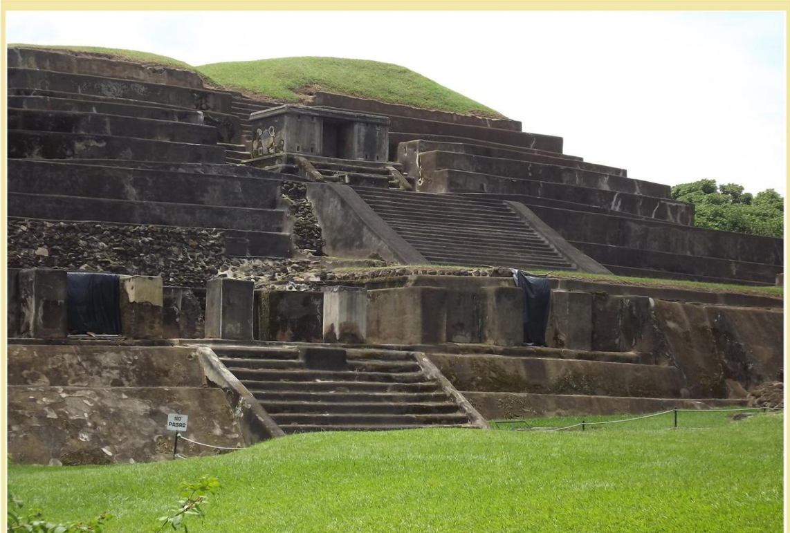
Fig 11. Estructura DB1-1, arquitectura posee características Toltecas y Teotihuacanas.
