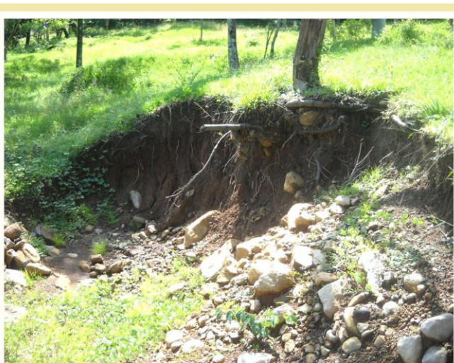
Fig. 49. Mina de barro de Quezaltepeque.
