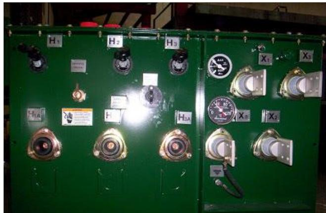
Figura 37: Transformador pedestal para conectar en red radial.
