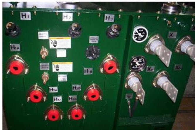
Figura 39: Transformador pedestal para conectar en red anillo.
