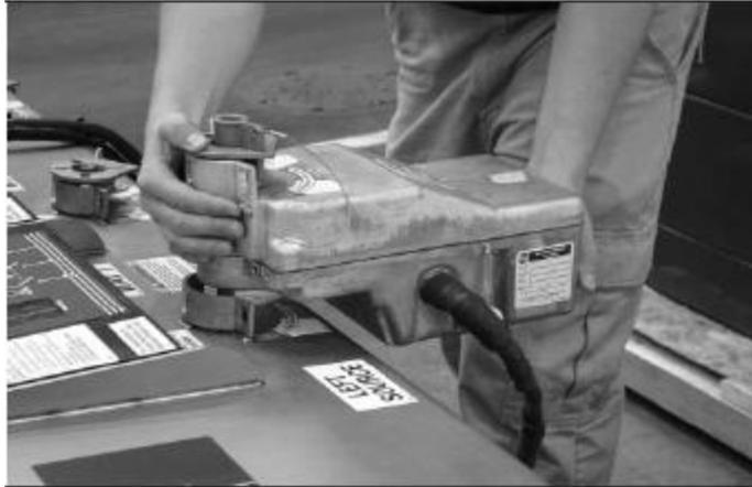
Figura 57: instalación de moto operadores para la automatización de los interruptores.
