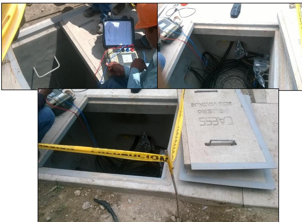
Figura 51: Prueba de resistencia de aislamiento de cable XLP y detalle superficial de pozo.
