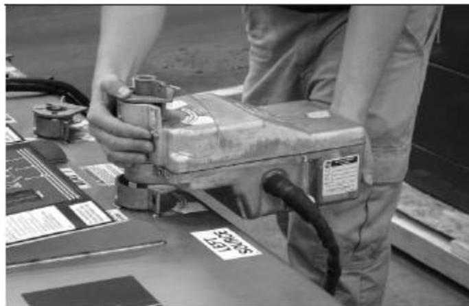
Figura 10: instalación de moto operadores para la automatización de los interruptores.
