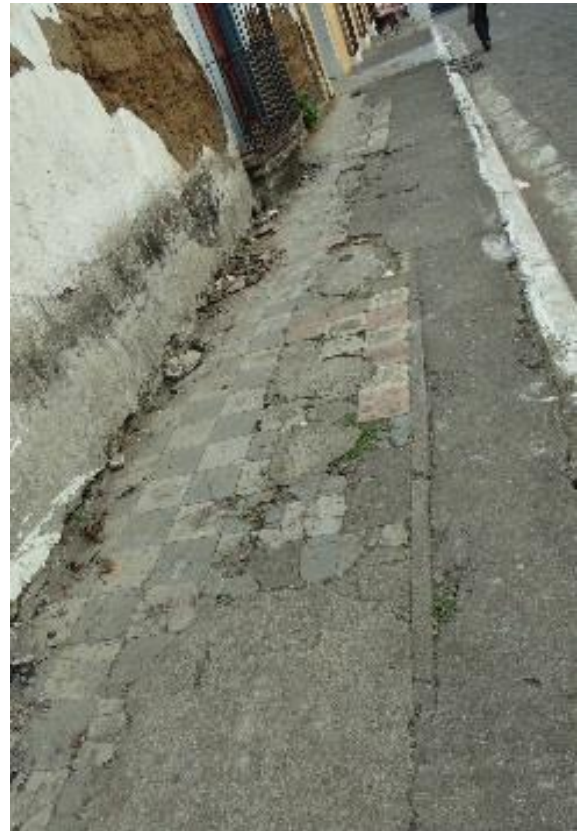
Ilustración 134: Vestigios piso de cemento de 20x20cm en acera exterior de diferentes épocas damero en gris claro y oscuro, y damero en rojo y gris.
