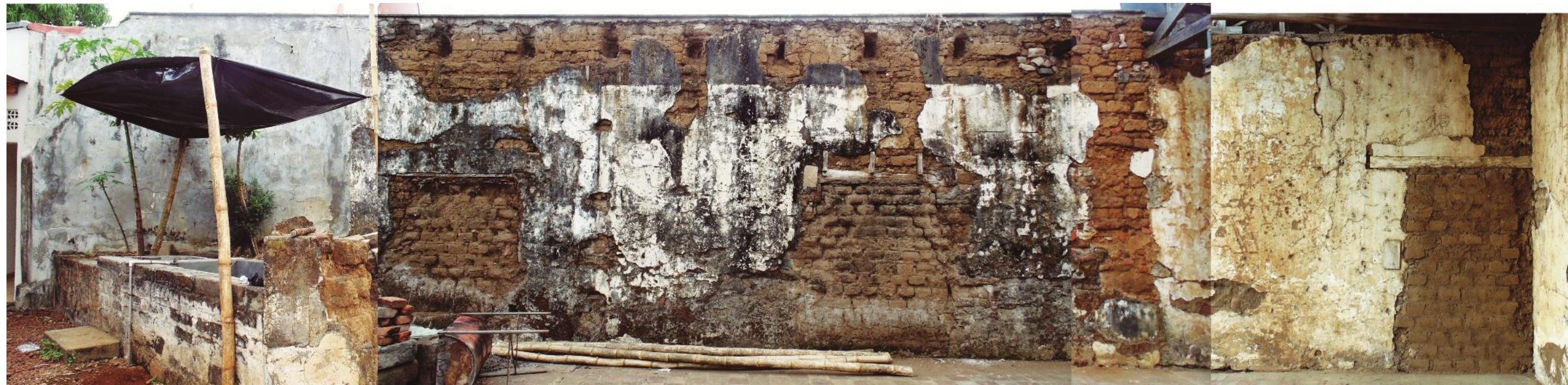
Ilustración 101: Elevación Corredor Sur, Eje 8 , vestigios de 3 vanos sellados con adobe, dos utilizados como alacenas y el de la derecha como puerta..
