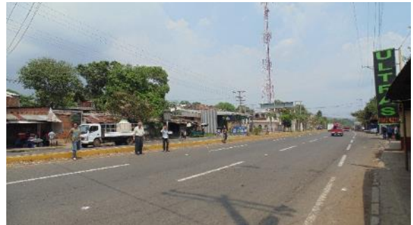
Ilustración 55: Carretera CA-8, hacia Lourdes Colon.
