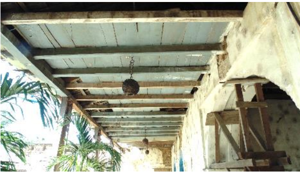
Ilustración 122: Cielo Tipo 02 en Corredores, actualmente solo existe en corredor Oeste.
