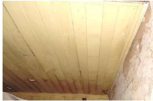
Ilustración 116: Cielo Tipo 01 de tablas superpuestas, existente en crujía Norte.
