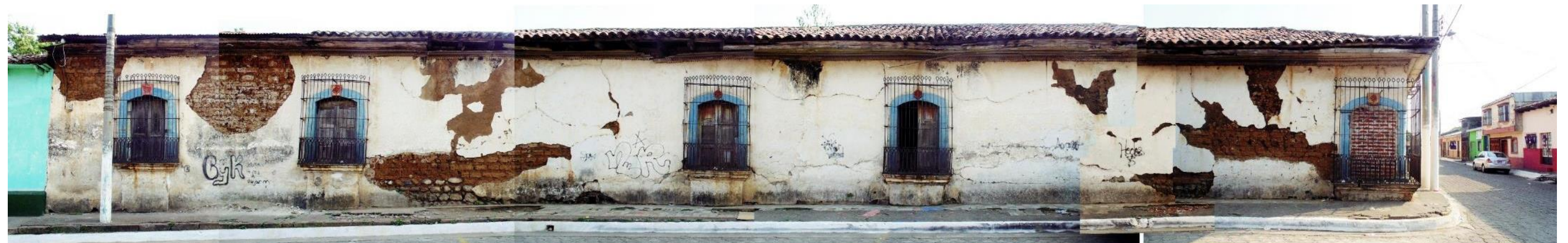
Ilustración 98: Elevación Norte, Eje 1 , cuenta con cinco ventanas y antepechos de alturas variables para adaptarse a la pendiente de la 1° Calle Poniente.
