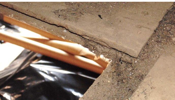
Ilustración 123: Vista superior del Cielo Tipo 02, se observa el sistema de unión machihembrado.
