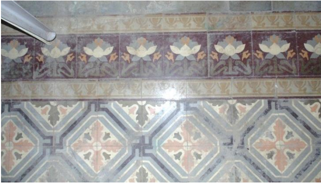
Ilustración 131: Piso de cemento tipo alfombra recuadro exterior con diseño diferente en Dormitorio 1.
