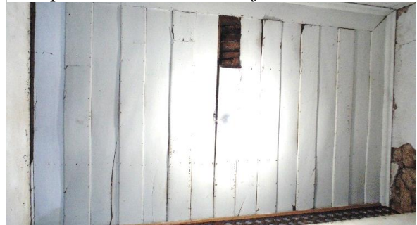
Ilustración 117: Cielo Tipo 01 de tablas superpuestas, existente en crujía Oeste.
