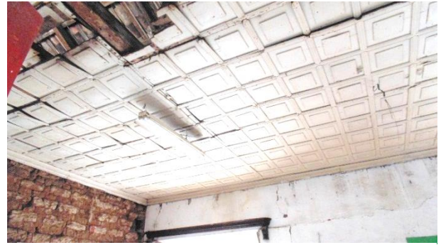
Ilustración 124: Cielo Tipo 03 de madera cedro, simulando un artesonado a menor escala con tableros rectangulares y molduras creando el efecto de vigas.
