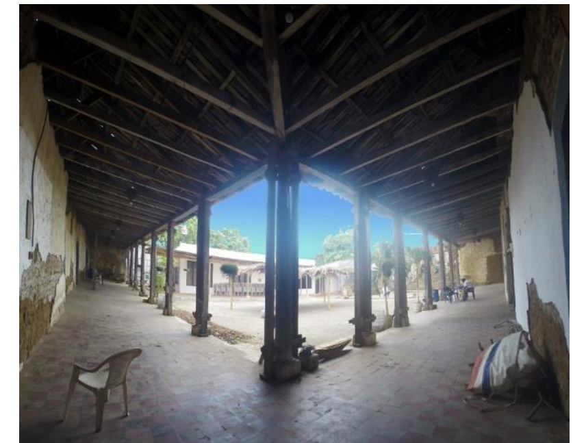
Ilustración 95: Vista de corredores Norte y Oeste en el perímetro del patio Central.
