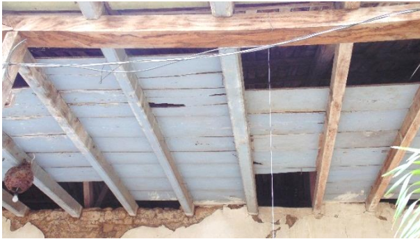
Ilustración 120: Estado actual de Cielo machihembrado de madera en corredor Oeste.
