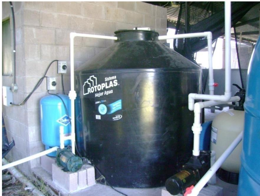
**Figura A8.** Bombas de succión con su respectivo tanque de presión.
