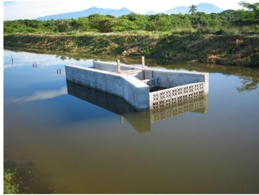
**Figura A3.** Punto filtrante de abastecimiento de agua salobre en proceso de filtración.
