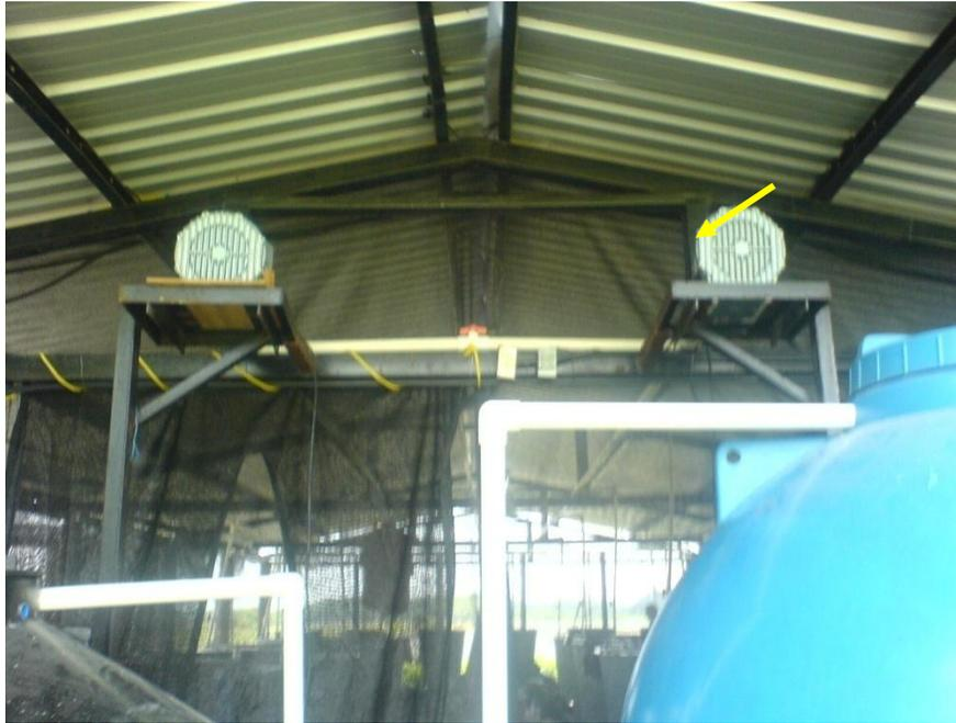
**Figura A11.** Sistema doble de compresores regenerativos, colocados sobre torretas.
