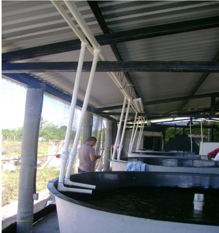
**Figura A7.** Tuberías de PVC, instalada sobre la estructura de la galera.
