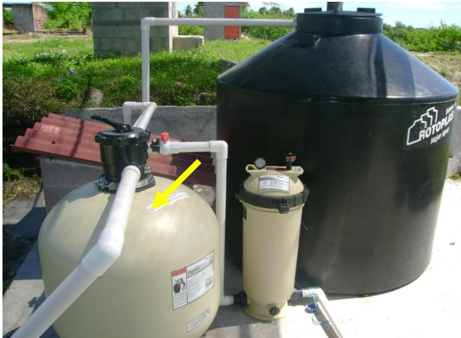
**Figura A5.** Filtro de arena de sílice con capacidad de 100 GPM.
