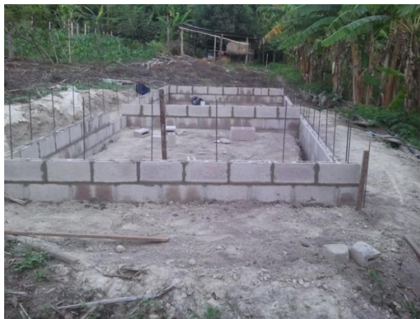
Figura 10: Construcción de corrales para el ensayo
