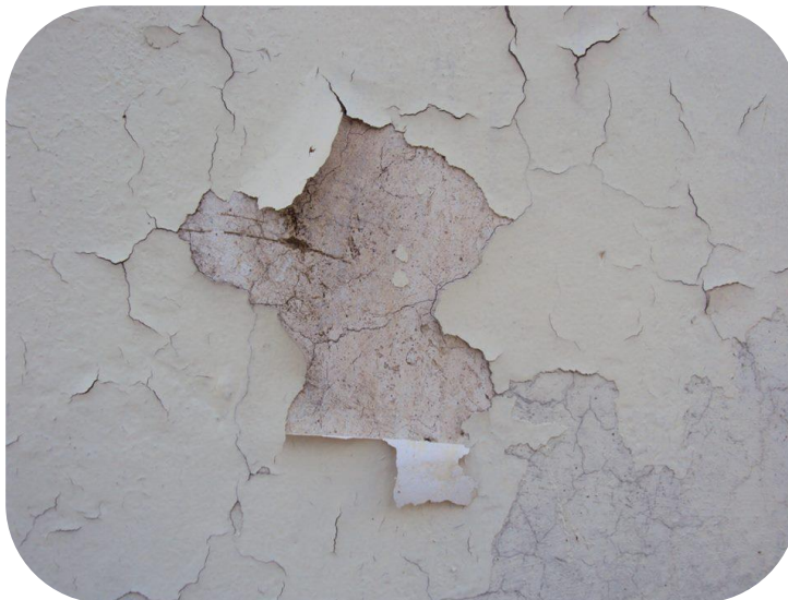
Daño de la capa protectora de pintura de la pared de Museo Fuente: Mauricio Morales Imagen: 42
