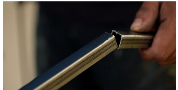
Corte del tubo con sierra para cortar hierro.
