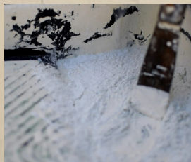
Preparación de pasta artesanal para curar grietas y agujeros en la pared.
