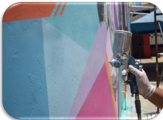
Elmer Ponce en la aplicación de la primera capa de barniz
