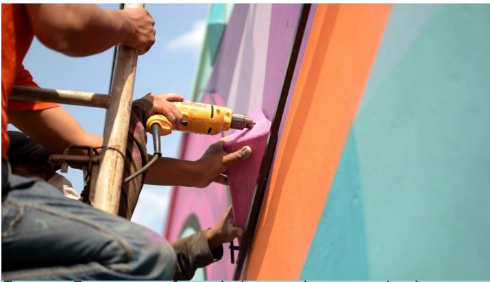
Raymon Barrera perforando la pared para anclar las piezas de resina
