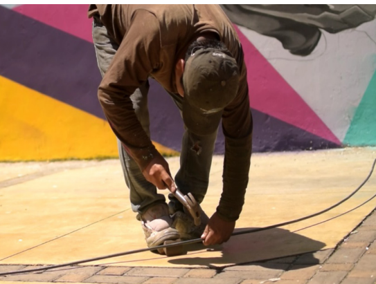
Elmer Ponce moldeando la varilla con martillo y yunque
