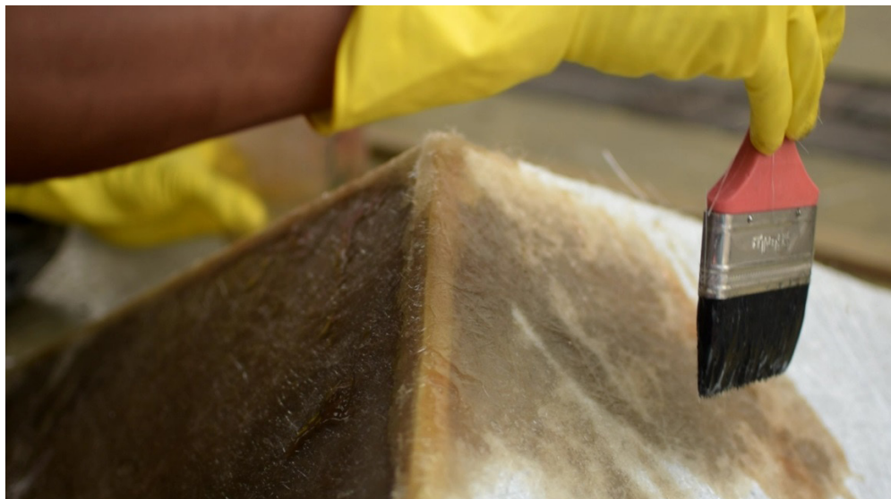
Mauricio Morales aplicando resina sobre la capa de fibra de vidrio.
