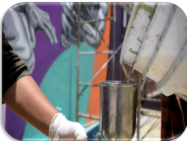
Elmer Ponce en el llenado de la pistola de gravedad para aplicar el barniz protector.
