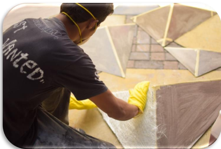
Mauricio Morales en la aplicación de la primera capa con fibra de vidrio Fuente: Raymond Barrera Imagen N° 97
