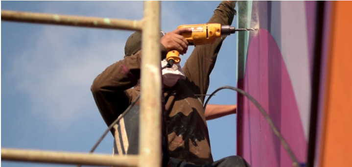
Elmer Ponce perforando los puntos de ensamblaje del hierro en la pared.
