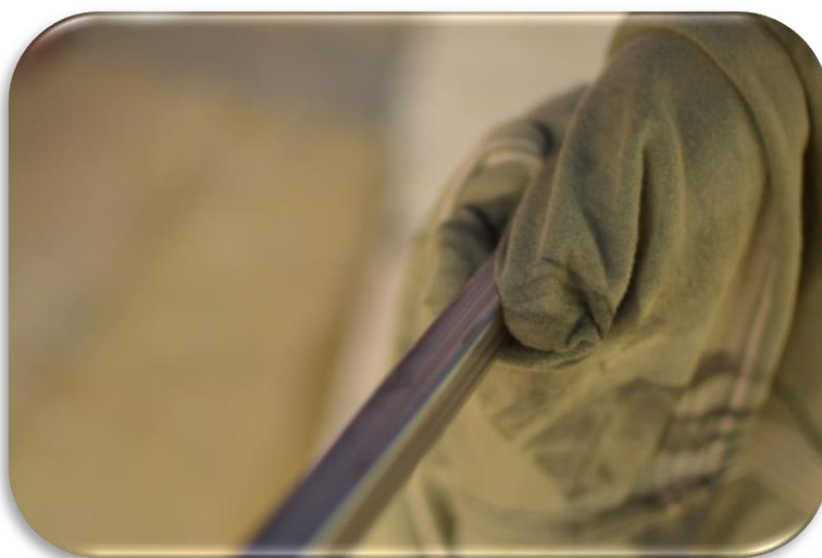
Limpieza de los tubos de hierro Fuente: Mauricio Morales Imagen Nº 85
