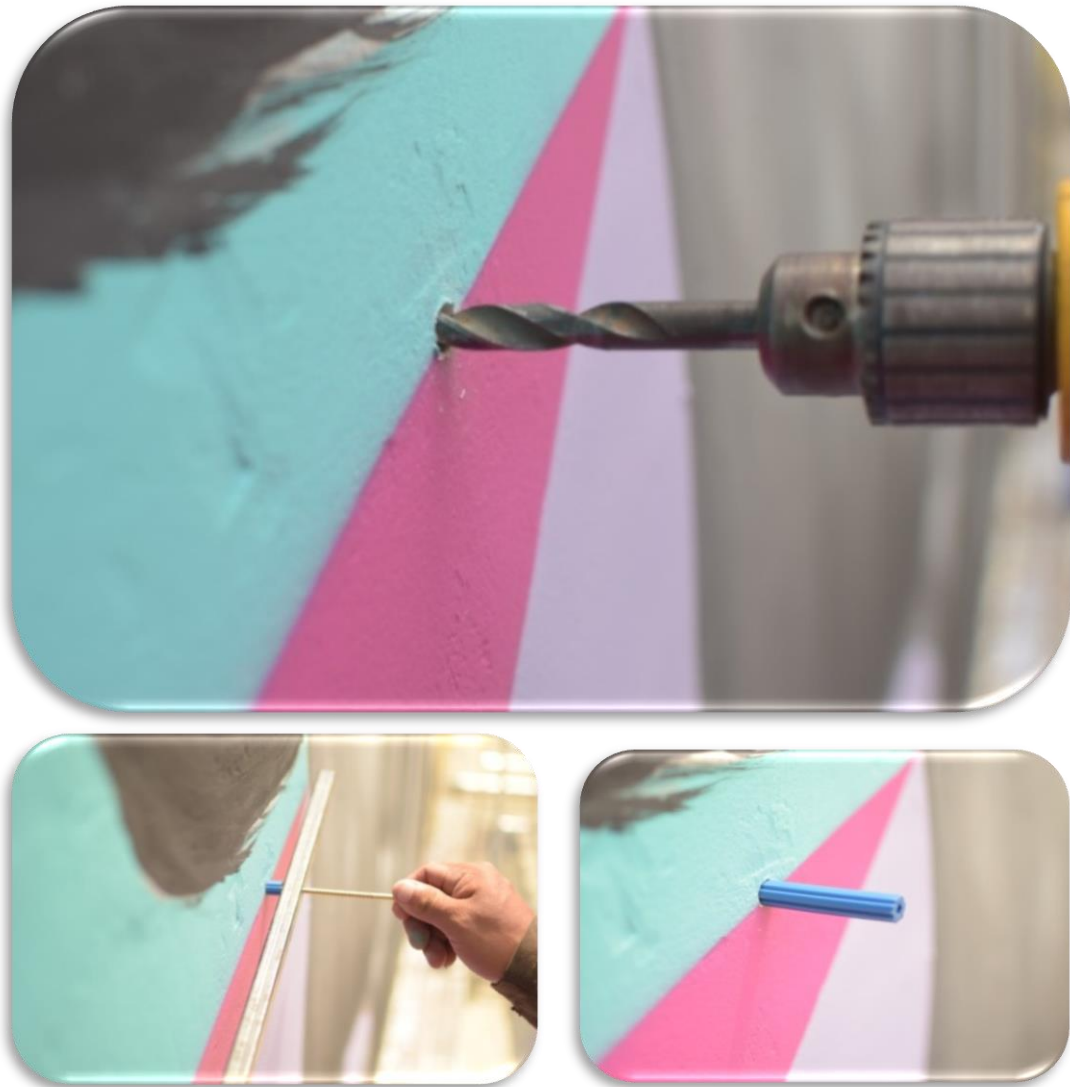
Perforación y colocación de los tubos metálicos Fuente: Mauricio Morales Imagen N° 90, 91, 92
