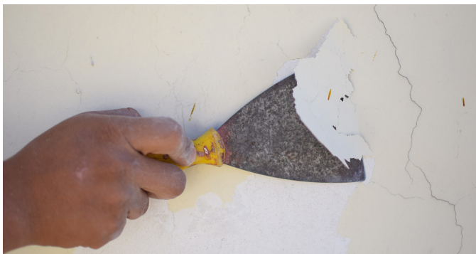
proceso de remoción de capas de pintura antiguas.
