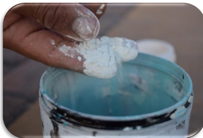
Raymon Barrera en el proceso de preparación de la mezcla pegamento, cemento y agua, e introducción de la mezcla dentro de la jeringa Fuente: Raymond Barrera Imagen N° 108, 109
