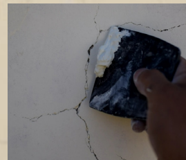
Preparación de pasta artesanal para curar grietas y agujeros en la pared.
