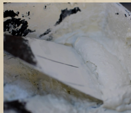
Preparación de pasta artesanal para curar grietas y agujeros en la pared.
