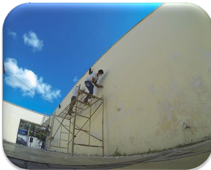
Raspado y ligado de pared Por parte del grupo de trabajo Fuente: Mauricio Morales Imagen N° 41
