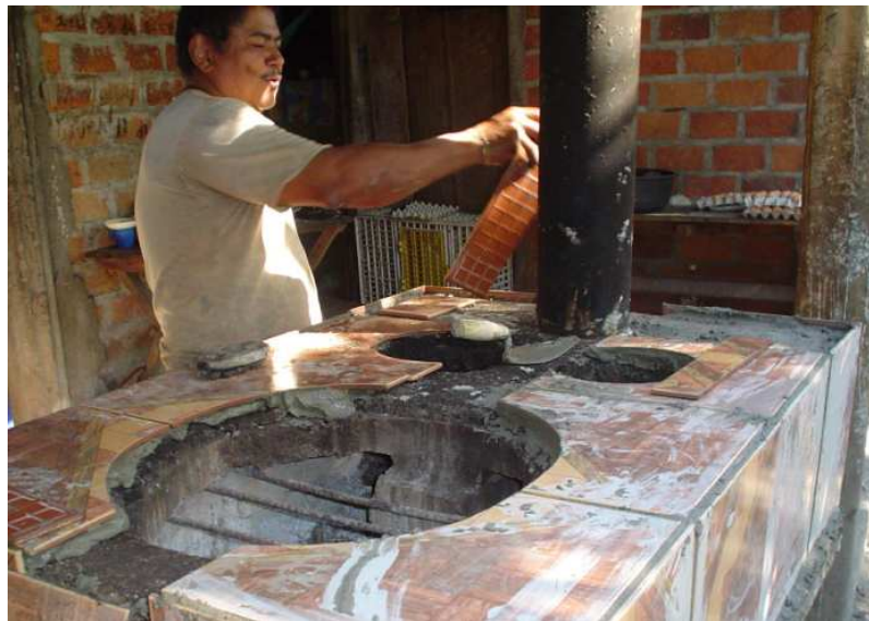
Fotografía A.8 Colocación de la Cerámica
