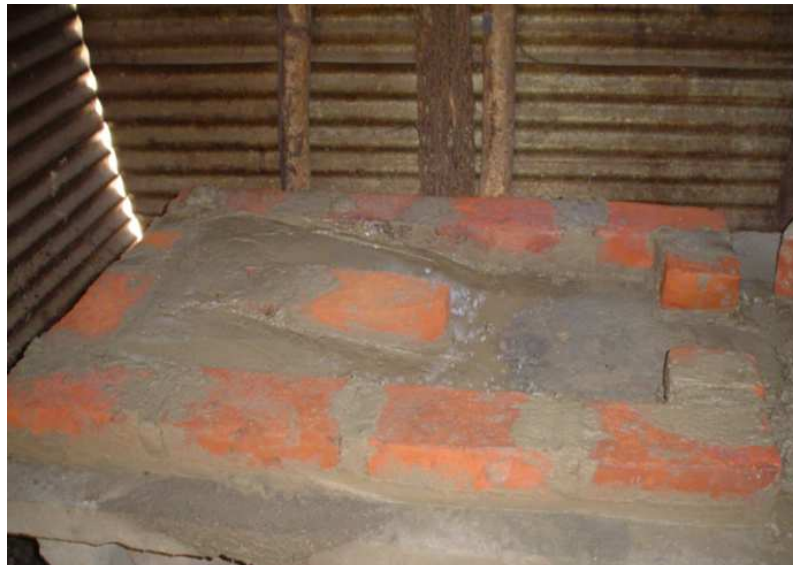
Fotografía A.4 Colocación de la primera hilada
