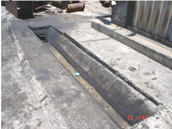
Figura 3.3.5: Canaleta de desagüe.
