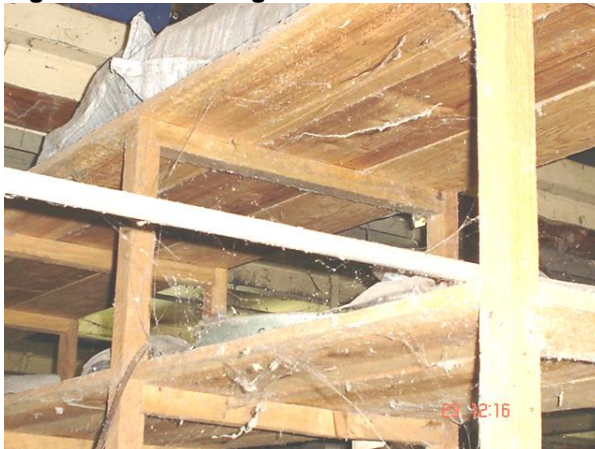
Figura 3.3.24: Bodega de Materiales.
