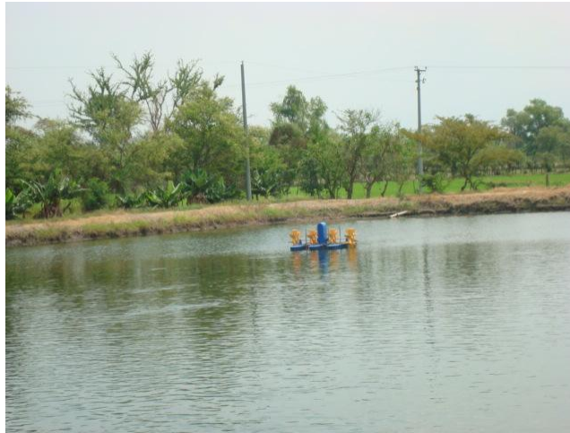
Vista al tercer estanque, el cual cuenta con máquina de oxigenación.
