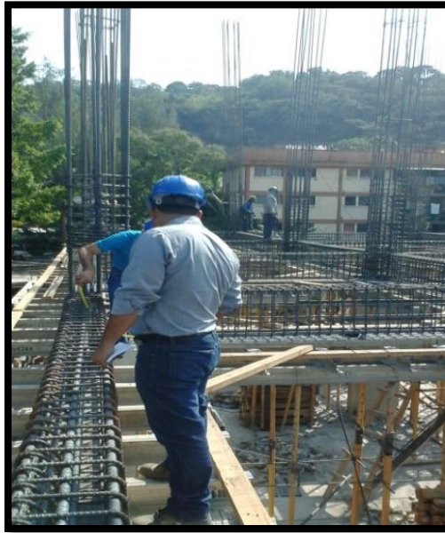
Imagen 3.27: Proceso de fabricación de una viga.
