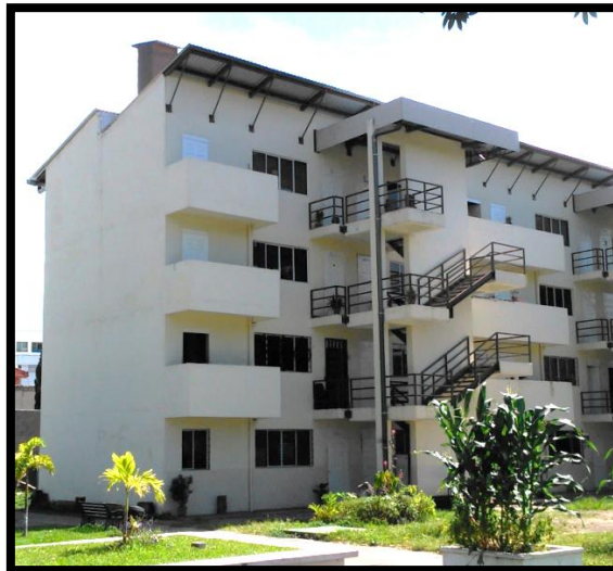
Imagen 1.14: Vista Lateral de Edificio "2", La Gran Manzana, Santa Tecla.
