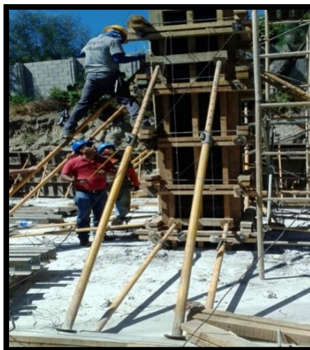
Imagen 3.25: Proceso de revisión del encofrado de una columna.
