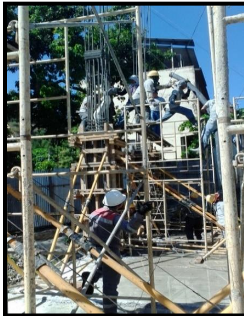
Imagen 3.26: Proceso de colado de una columna.
