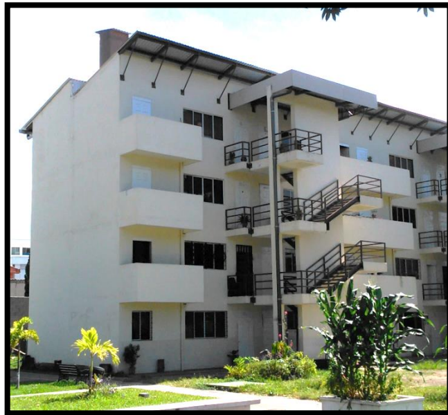
Imagen 4.2: Vista Lateral de Edificio "2", La Gran Manzana, Santa Tecla.
