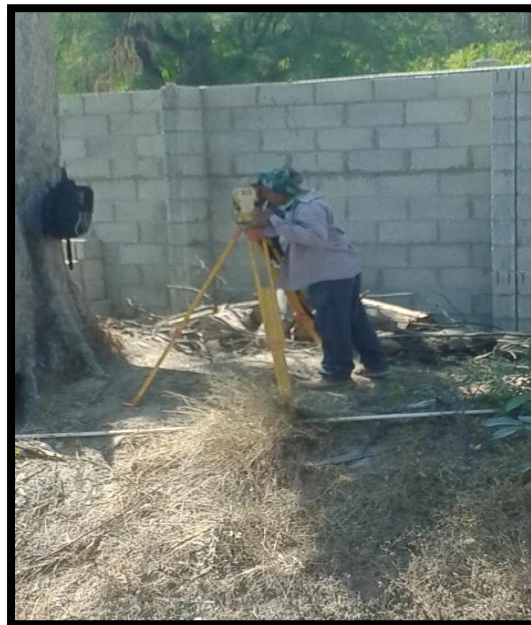
Imagen 3.7: Levantamiento topográfico del terreno de la obra.
