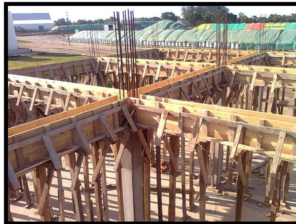
Imagen 3.19: Encofrados para vigas (Fuente: http://www.cuevadelcivil.com/2015/10/construccion-de-vigas-de-hormigon-armado.html )
