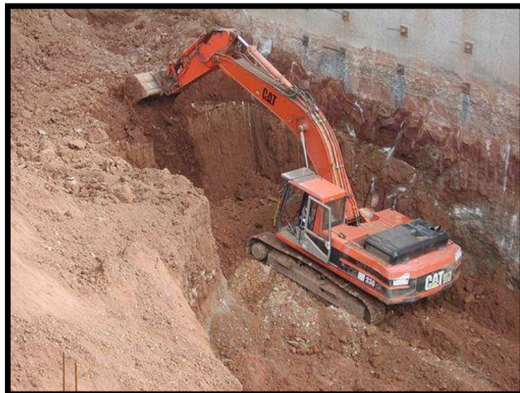
Imagen 3.14: Proceso de excavación en campo (Fuente: http://www.arqhys.com/construccion/excavaciones-estructurales.html ).
