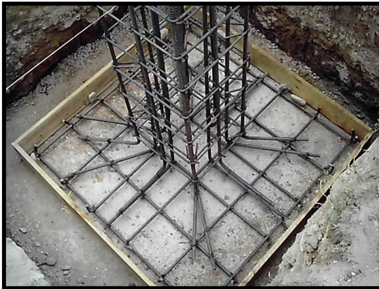
Imagen 3.23: Encofrado en cimentaciones (Fuente: http://www.civilexcel.com/2012/06/disenio-de-zapata-aislada.html ).
