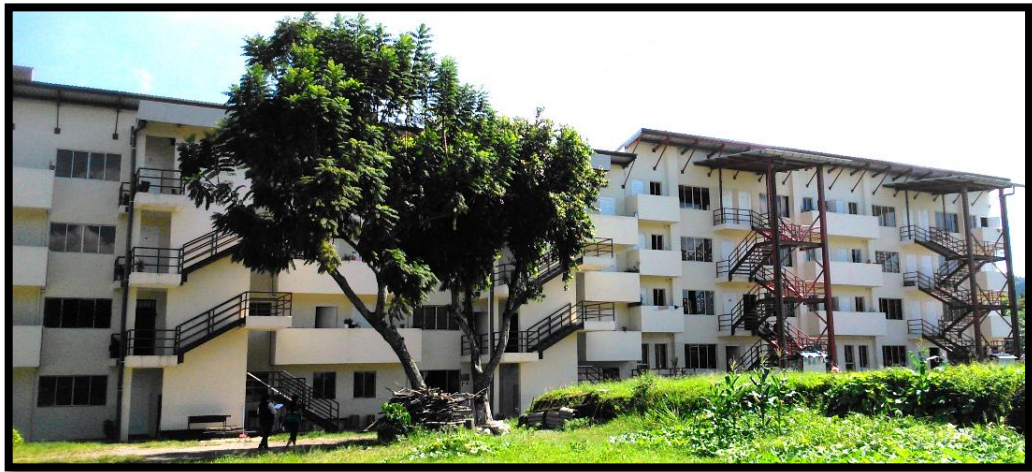
Imagen 4.1: Fachada de Edificio "2", La Gran Manzana, Santa Tecla, El Salvador.
