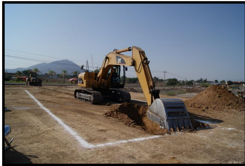
Imagen 4.16: Excavación en campo (Fuente: https://constructoratsc.wordpress.com/construccion/estaciones-de-servicio/ )
