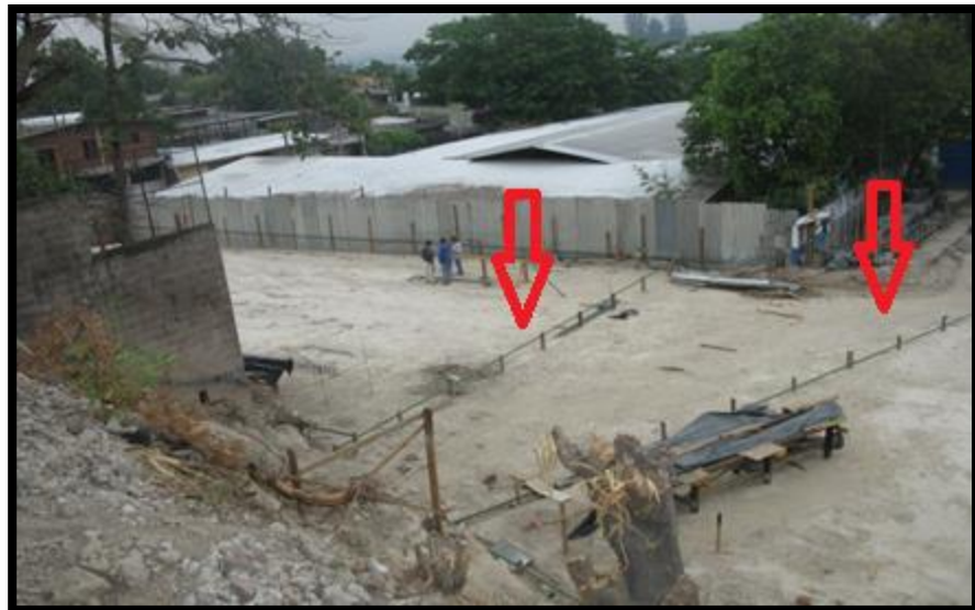
Imagen 3.13: Proceso de elaboración de trazos en campo.
