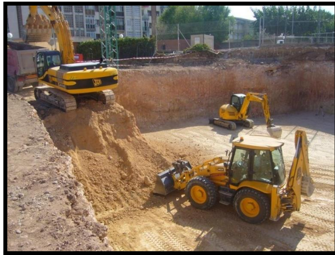
Imagen 4.17: Relleno y acarreo de material selecto (Fuente: http://www.transcaz.com/la-empresa/maquinaria )
