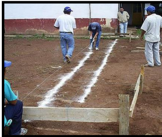
Imagen 4.15: Nivelación y Trazo en campo (Fuente: http://administracionequipo5.blogspot.com/2012/02/1-el-sitio.html ).
