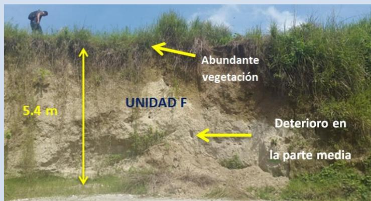
**Figura No. 4.9 Estratigrafía del talud Galicia**
