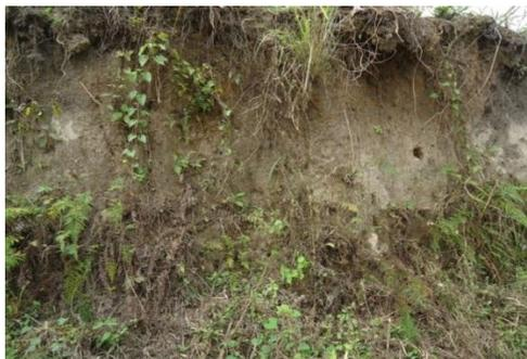
**Figura No. 2.17 Capa vegetal como protección del talud**
