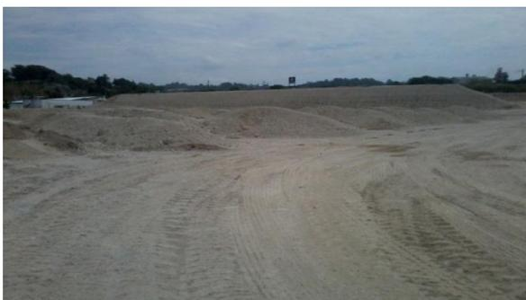
**Figura No. 2.25. Remoción de la capa vegetativa del suelo por intervención antrópica provocando erosión eólica en la zona del municipio de Ilopango.**
