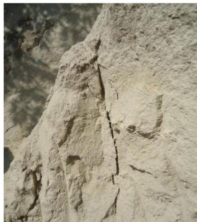
**Figura No. 2.14** Proceso de exfoliación de las capas de los taludes
