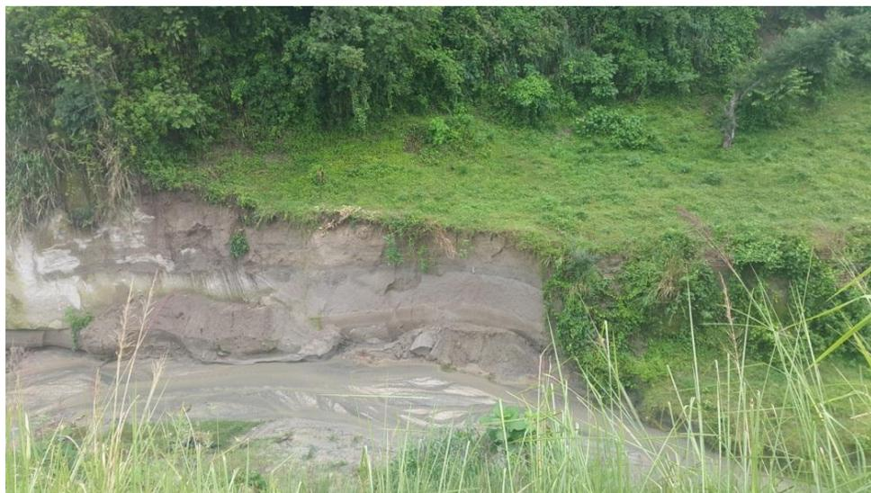
**Figura No. 4.41 Ejemplo de talud para aplicar la Técnica “A”. Talud con superficie aproximadamente plana en la cresta y expuesto a erosión lateral.**
