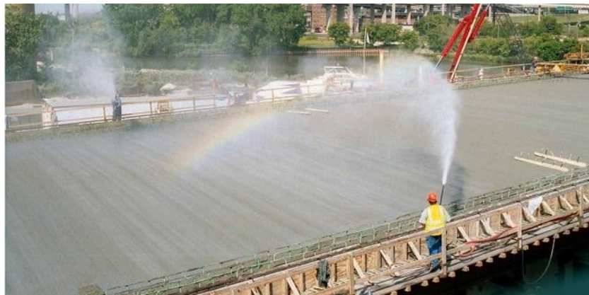
Figura 4.40 Curado de losa por inundación.
