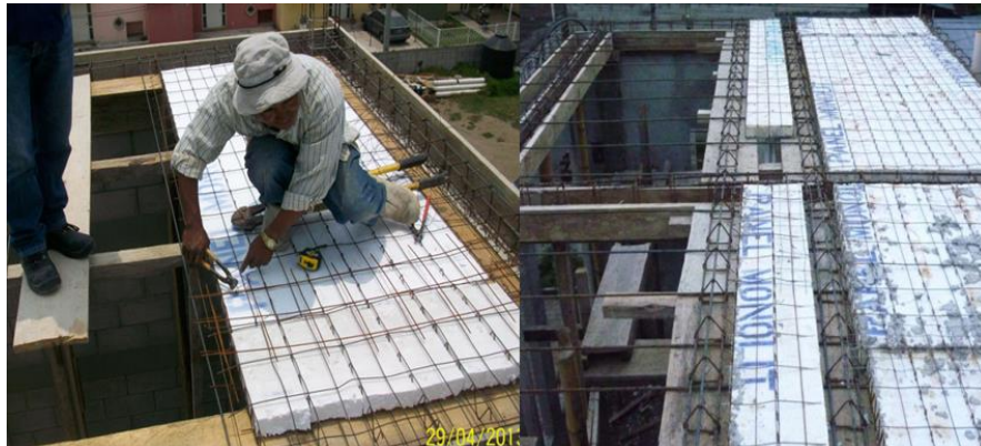
Figura 4.1 Instalación de losa de panel aislante en campo.
