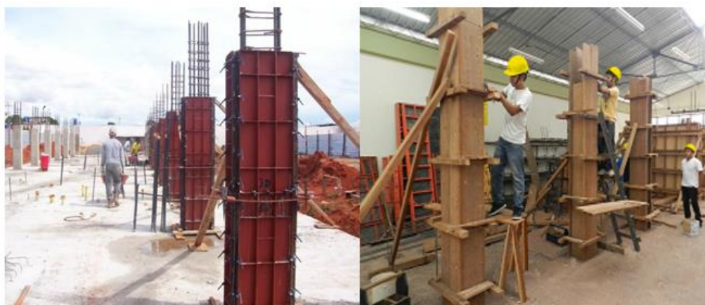
b) Encofrado metálico de columna a) Encofrado de madera en columna
