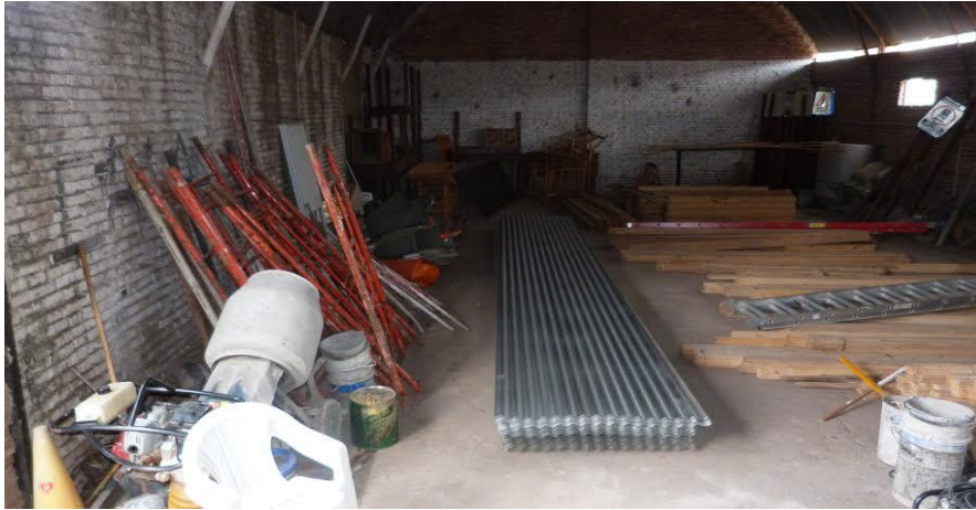
Figura 2.14 Almacenaje ordenado de materiales en bodega.
