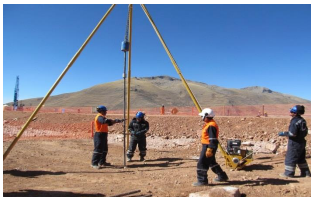
Figura 2.10 Prueba de cimentación estándar (SPT), ensayo necesario para cualquier estudio de suelo para una edificación.
