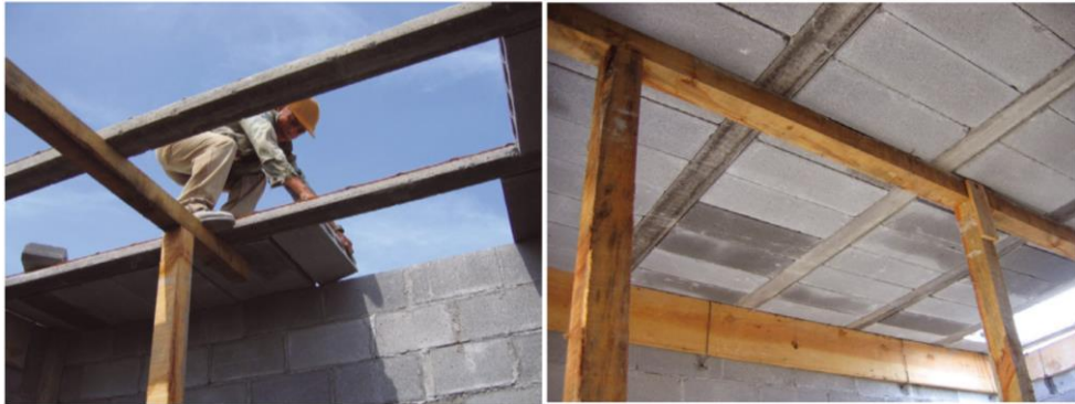
Figura 4.33 Colocación de bovedilla y finalización de tablero.
