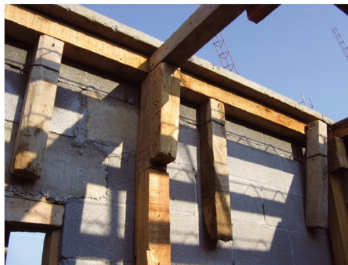
Figura 4.29 Colocación de la cimbra.
