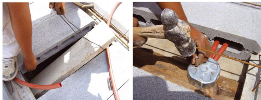
Figura 4.35 Colocación de madera en el hueco donde se instalará una caja para lámpara. Instalación de caja.
