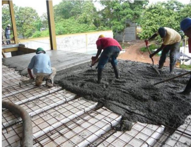
Figura 4.9 Colocación de concreto para losa aligerada.
