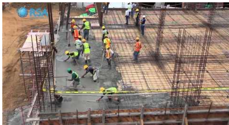
Figura 4.39 Colado de concreto en losa aligerada.
