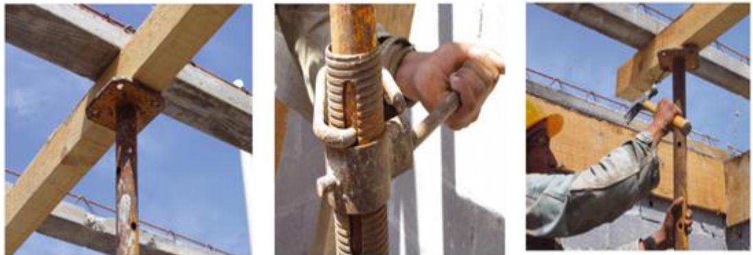
Figura 4.32 Colocación, plomo y ajuste de puntales.
