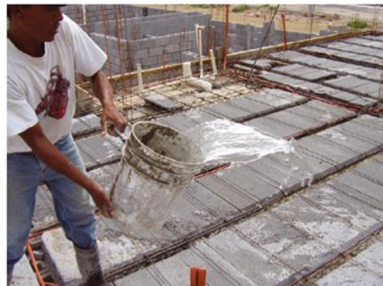
Figura 4.38 Humedecimiento de bovedillas.
