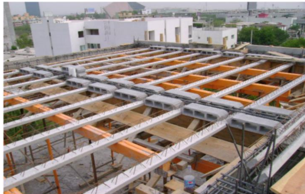
Figura 4.30 Alineamiento correcto de viguetas.
