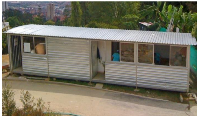
Figura 2.12 Instalación provisional de la más sencilla elaborada con costanera y láminas.
