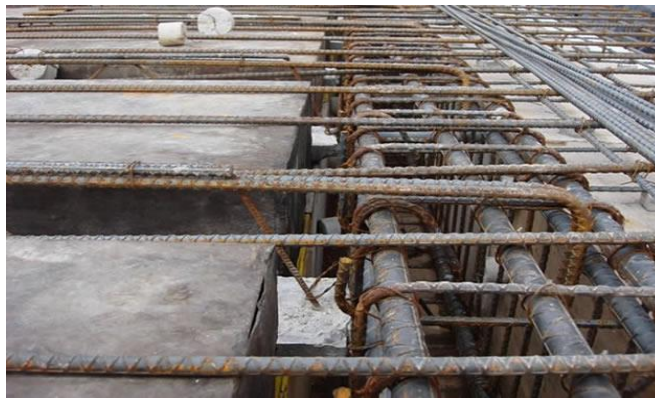
Figura 4.36 Colocación de bastones.
