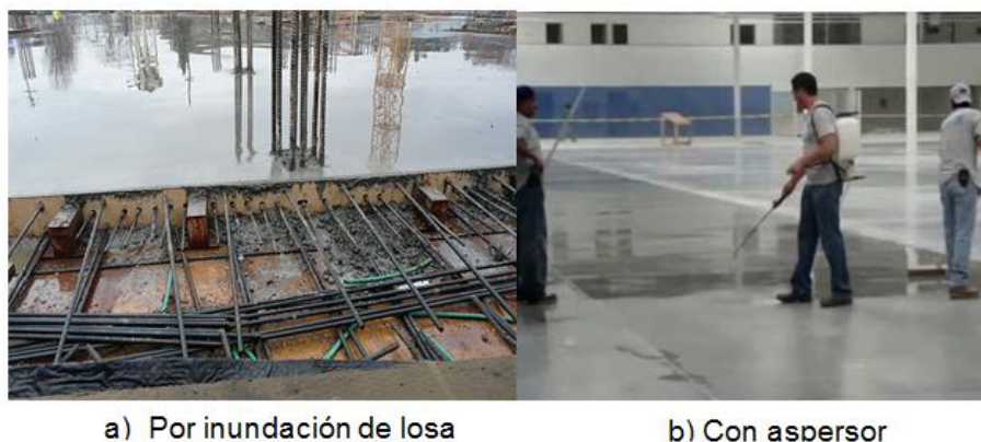
Figura 2.16 Curado tradicional del concreto en endurecimiento y monolitización con agua y curado con aditivo.
