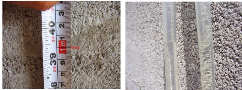
Figura 4.28 Traslado de niveles para colocación cuartones.
