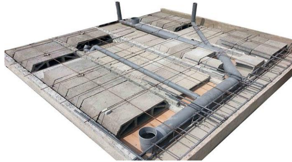
Figura 4.34 Colocación de tuberías en losa de entrepiso.
