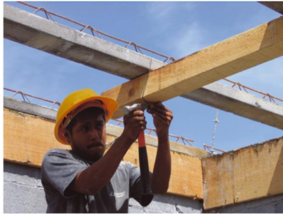
Figura 4.31 Colocación de cuarterones amarrados con alambre de amarre.
