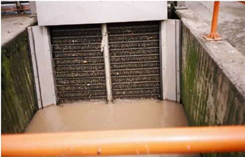
Figura 3.1. Pretratamiento de aguas con rejillas. Fuente: Collazos C., 2009.
