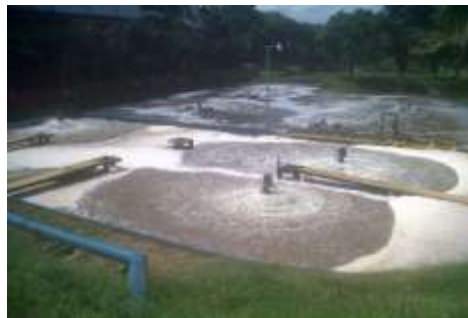
Figura 3.7. Tratamiento con lodos activados. Fuente: Berzosa J., 2016.
