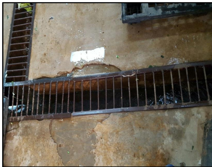
Figura N°12: Drenajes de la planta ACOPO de R.L
