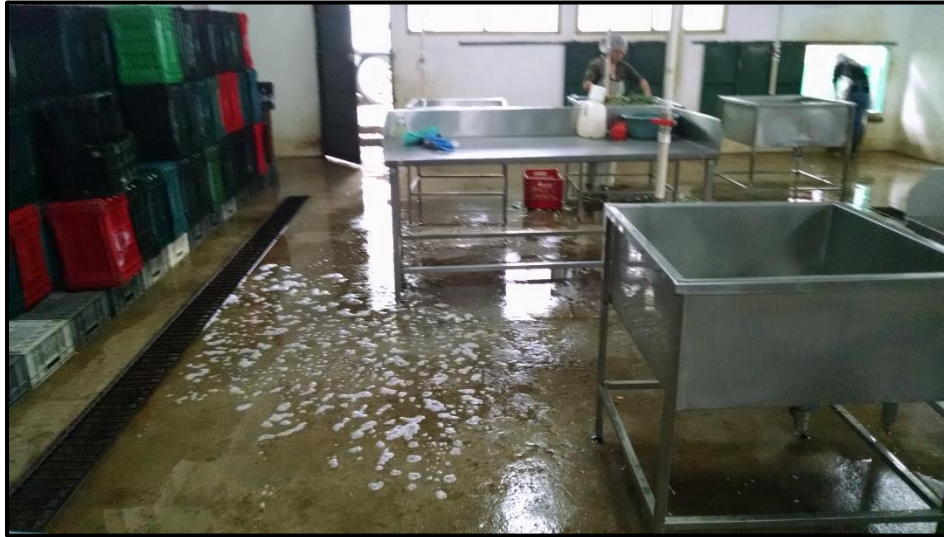
Figura N°11: Pisos y Ventanas de la planta ACOPO de R.L
