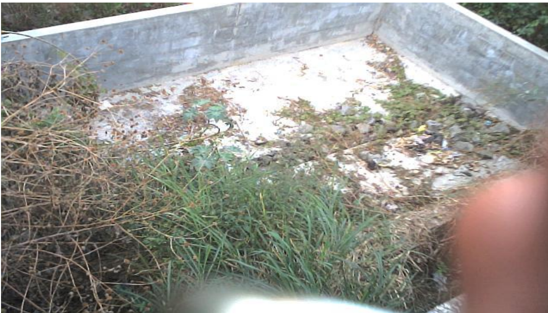
Fig. 3.2.1.7 Helechos para secado de lodos activados de la planta Altos del Escorial que se encuentra sin uso y abandonada.
