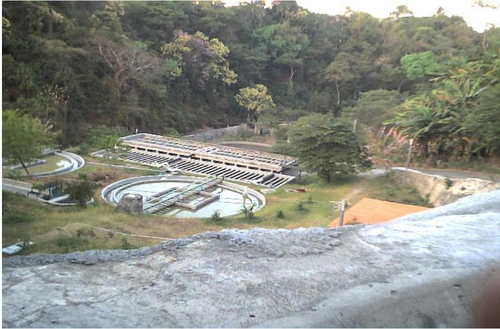
Fig. 3.2.1 Planta de tratamiento de la Santísima Trinidad, donde se observan los sedimentadores primarios, secundarios y los filtros biológicos
