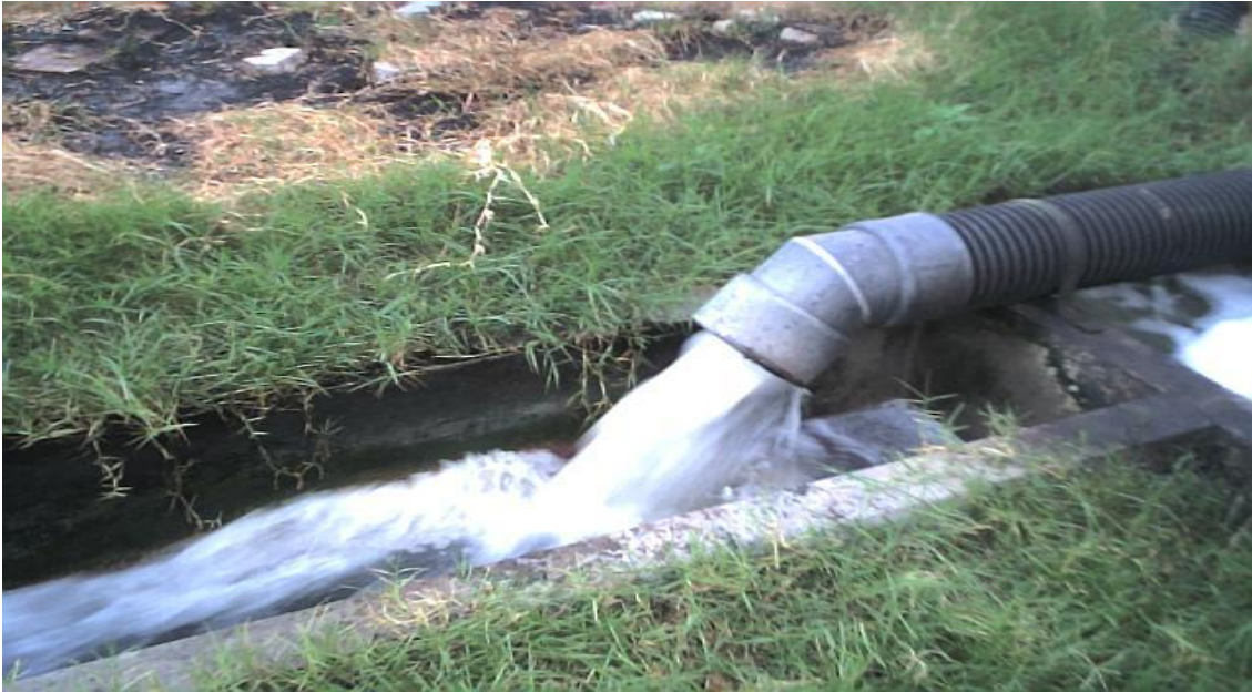
Fig. 3.2.1.5 El agua “limpia” es enviada por una tubería hacia una quebrada cercana, de la planta de tratamiento Santísima Trinidad.
