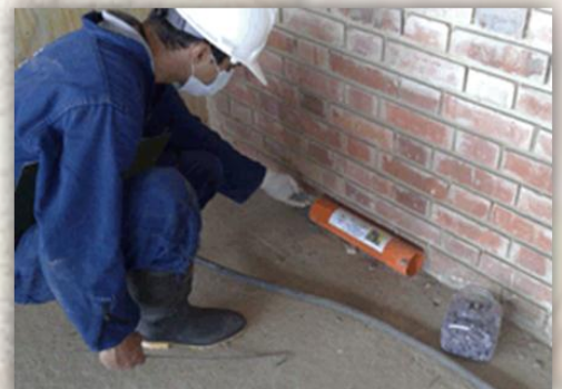
Fig 8.2 Aplicación de químico
