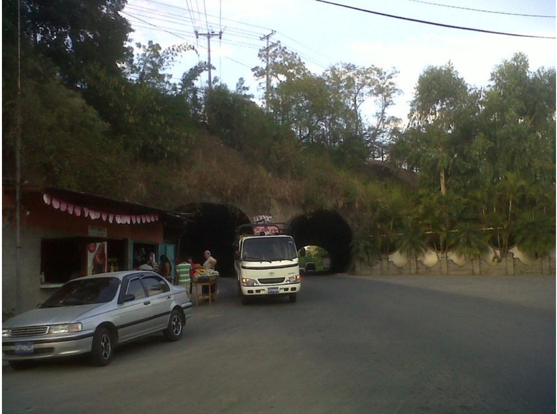
FUENTE: Túnel y la calle principal que divide la comunidad el cañito y jardines del recuerdo. Fotografía tomada por seminaristas. 02/03/2012.
