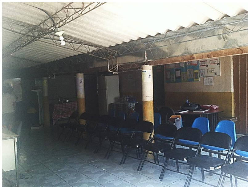
Fotografía 1. Infraestructura interna de Ecos El Rosario, San Martín. Fotografía tomada por Irma Vides en marzo, 2014.
