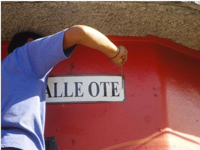
Foto 65: **Colocación con anclas y tornillos**
