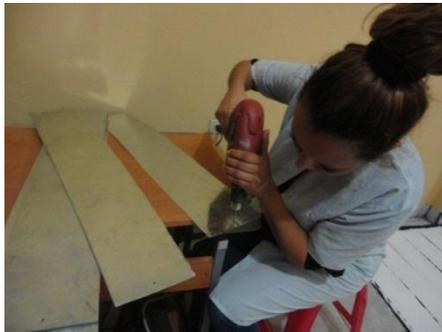
Foto 46: **Perforación de láminas para posterior colocación**
