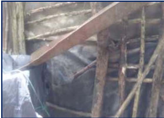
Canales inadecuados para la bajada de agua a los depósitos de recolección
