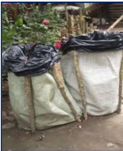
Canales inadecuados para la bajada de agua a los depósitos de recolección
