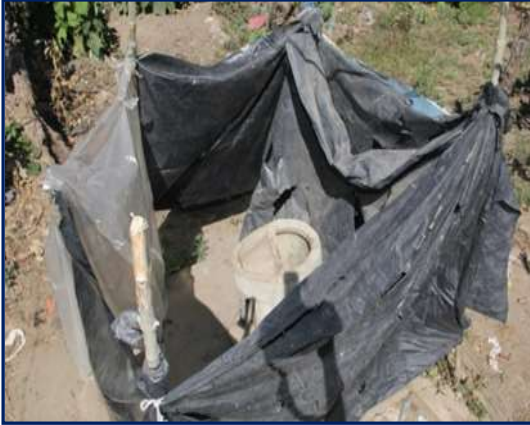
Casos extremos, letrinas sin paredes, ni techos
