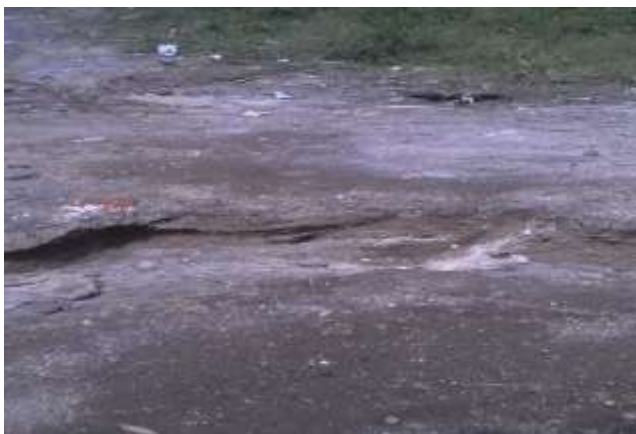
Tramo para empedrado fraguado, badén y cordón cuneta
