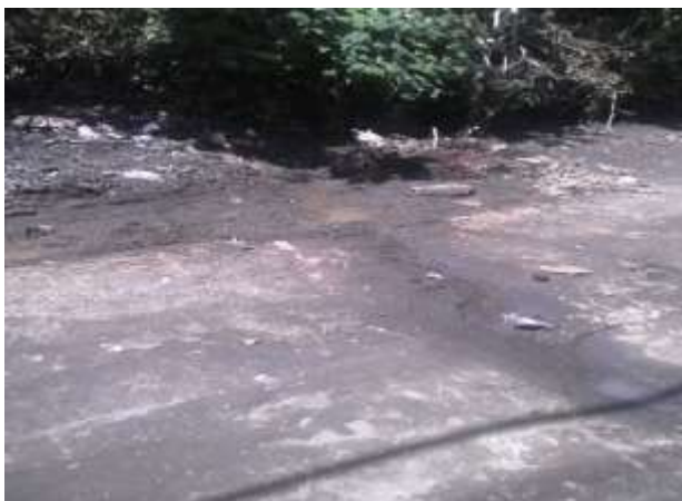
Tramo para empedrado fraguado, badén y cordón cuneta
