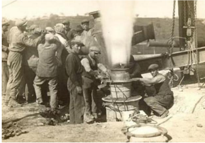
Figura 5. Primera planta geotérmica construida en Lardarello en 1911 6
