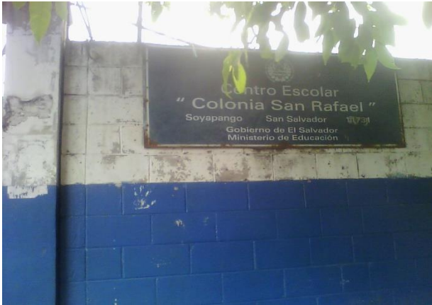
Muro de la entrada principal.
