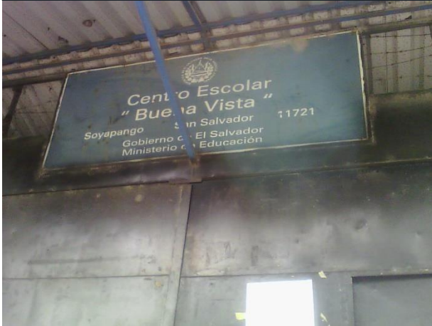
Entrada principal del centro escolar.
