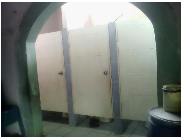
Área de los servicios sanitarios.
