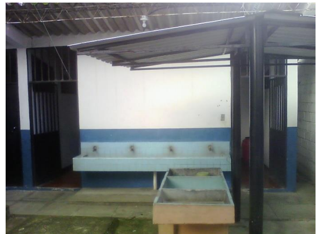
Zona donde están los servicios sanitarios
