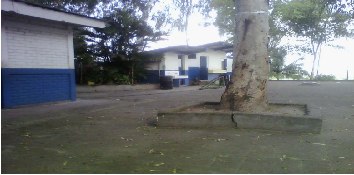
Parte del área de recreación y al fondo los servicios sanitarios del centro escolar.
