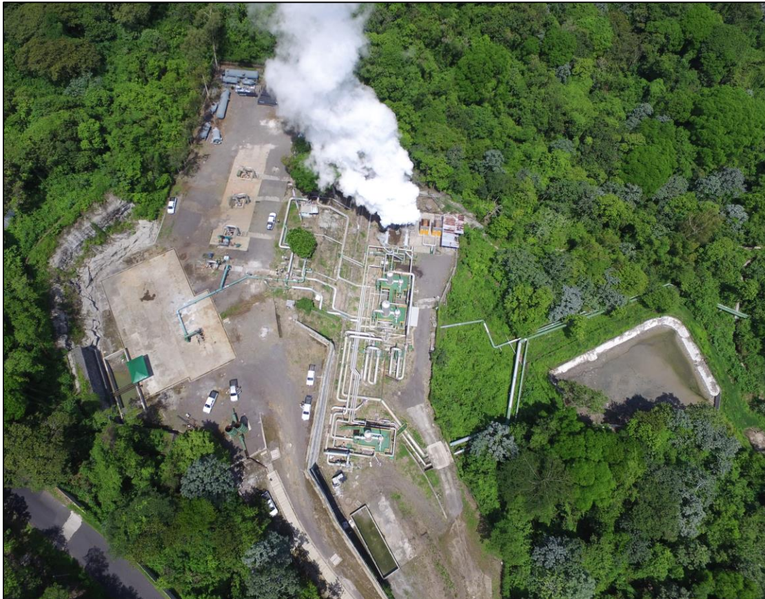
Fig. 1 disposición de equipos en plataforma geotérmica para producción.
