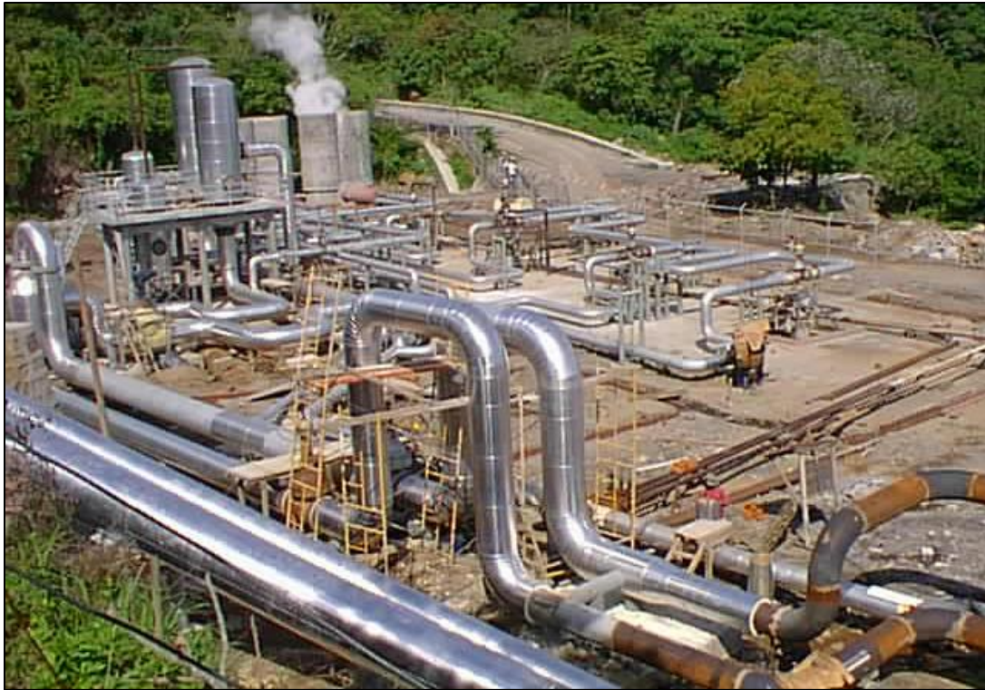
Fig. 18 Montaje de sistema de acarreo, tipo superficial, en plataforma DG-01
